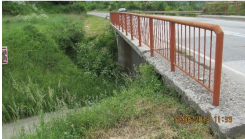
Слика 28. Мост преко локалног пута на км 241+323
