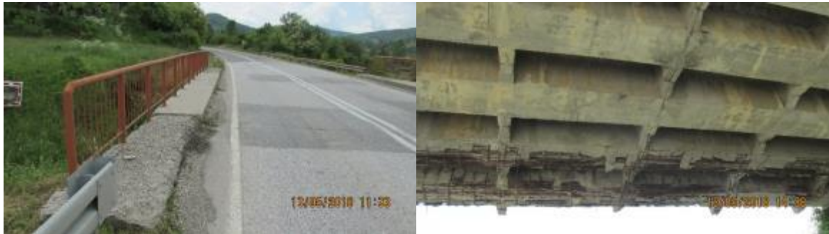
Слика 12. Типична оштећења на мостовима
