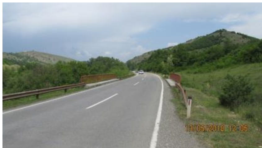
Слика 29. Мост преко локалног пута на км 244+058
