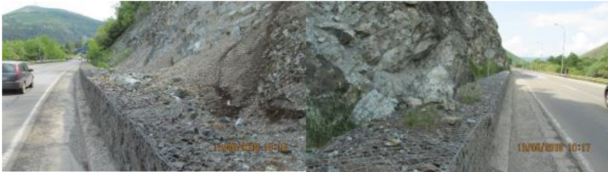
Слика 9. Габиони на предметној деоници
