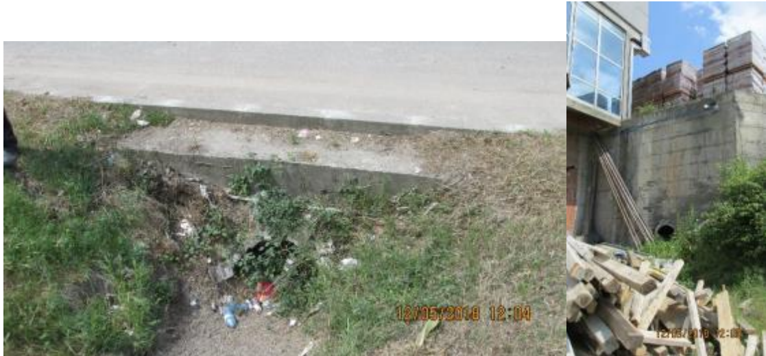
Слика 26. Цеваста пропуст на 249+784, Уливна и изливна грађевина пропуста
