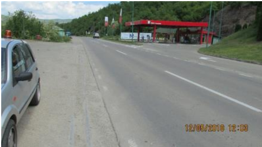
Слика 15. Бензинска станица "М Петрол" на км 249+720
