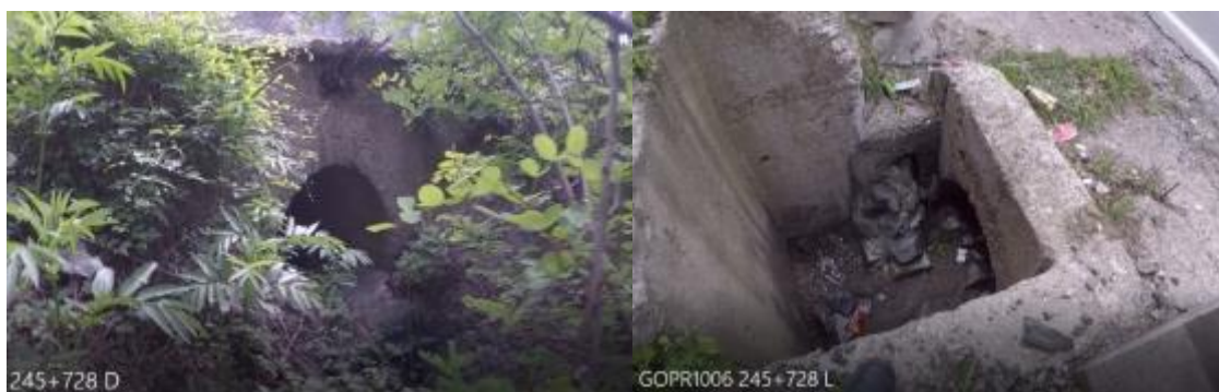
Слика 25. Засведен пропуст на 245+728, Уливна и изливна грађевина пропуста
