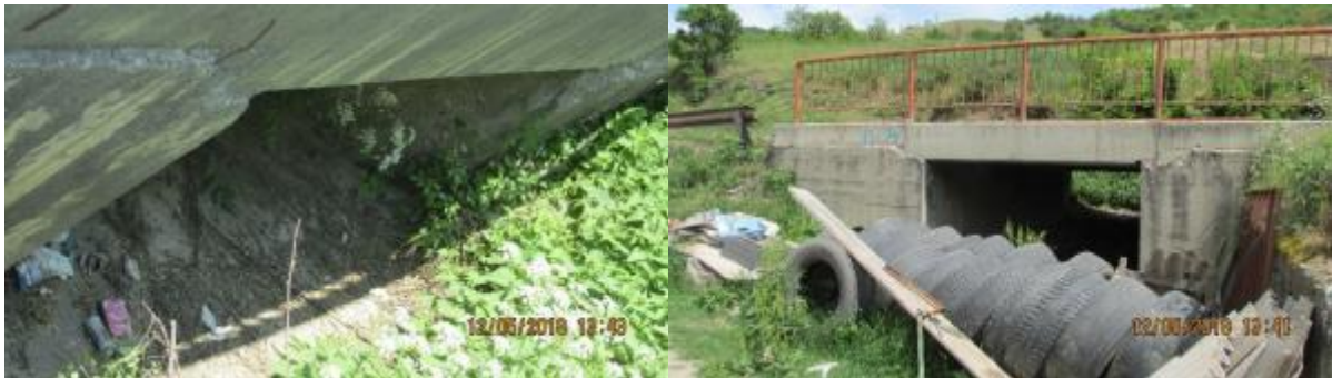
Слика 27. Плочаста пропуст на км 250+790, улив и излив пропуста
