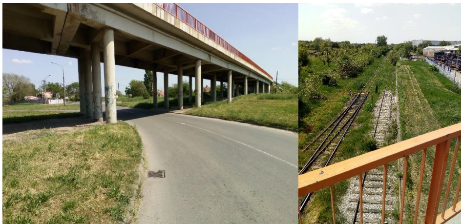
Слика 20. Беков надвожњак на км 124+060
