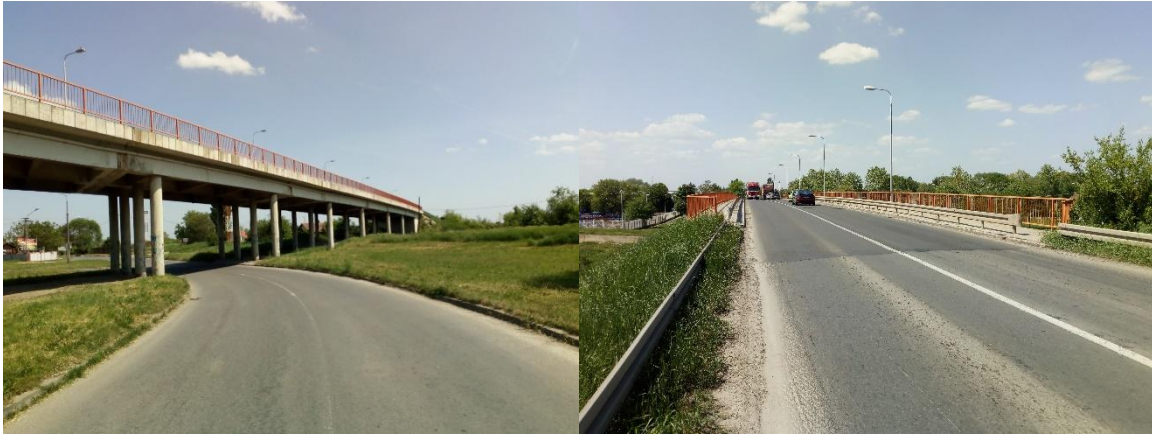
Слика 7. Беков надвожњак на км 124+060
