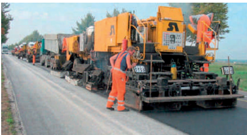
Сл. 5.34 – Прерада постојећег и наношење новог асфалтног слоја, (РЕМИКС+)
