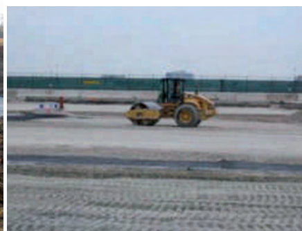
Сл. 1.14 – Побољшање темељног тла ПВЦ фолијом
