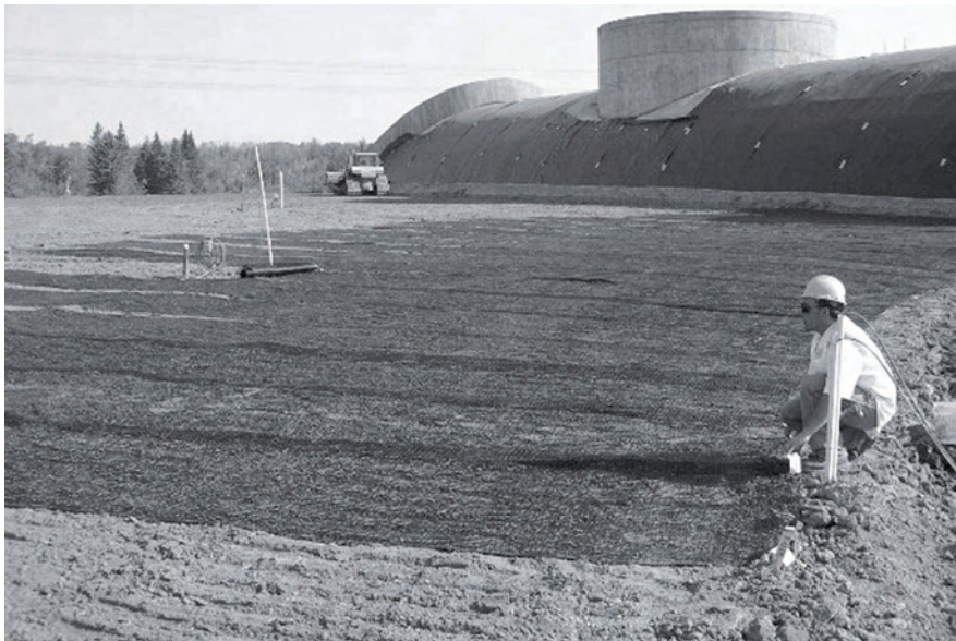
Сл. 1.16 – Постављање геомреже, (геотекстила)
