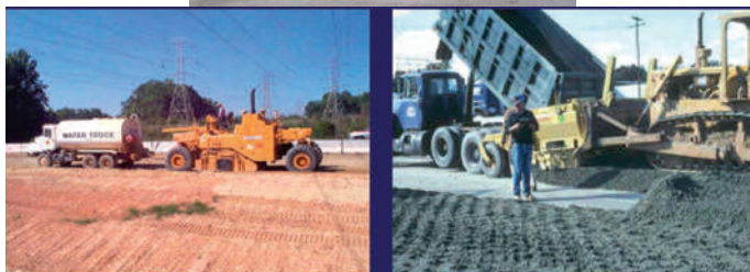
Сл. 5.42 – Стабилизација материјала може се обављати у стабилним постројењима и на лицу места
