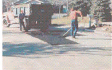
Сл. 4.18 – Пример поправке рупе у коловозној конструкцији
