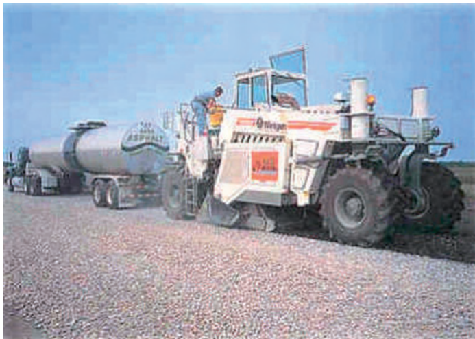
Сл. 5.9 – Механизација за рециклажу по хладном поступку са додатком цемента
