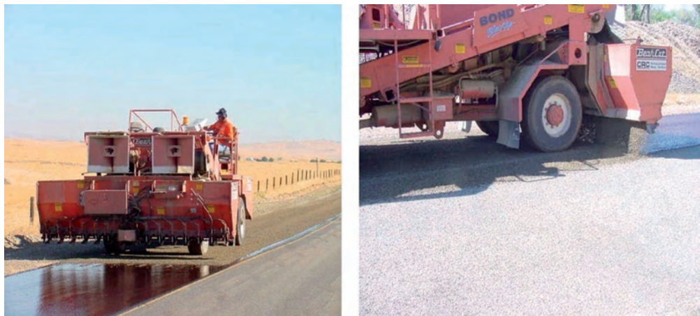
Сл. 5.40 – Разастирање агрегата
