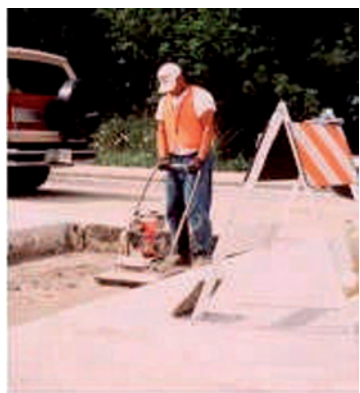
Сл. 4.17 – Редослед активности код поправке рупа у коловозним конструкцијама
