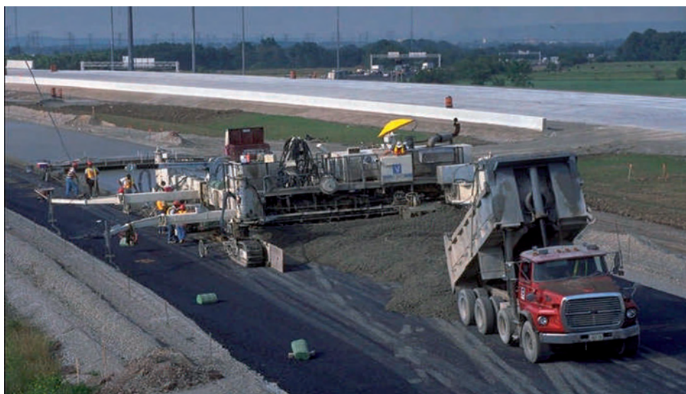
Сл. 6.16 – Транспорт бетона и уграђивање
