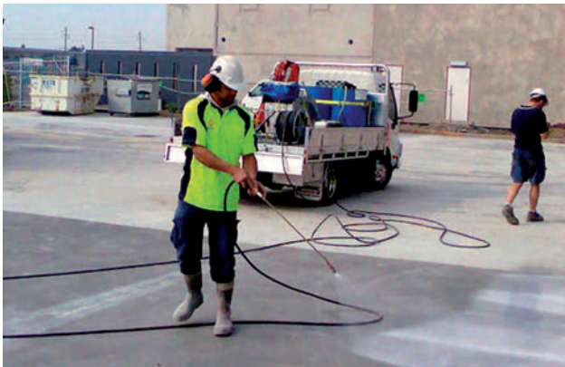
Сл. 6.7 – Поступак наношења средства за неговање бетона
