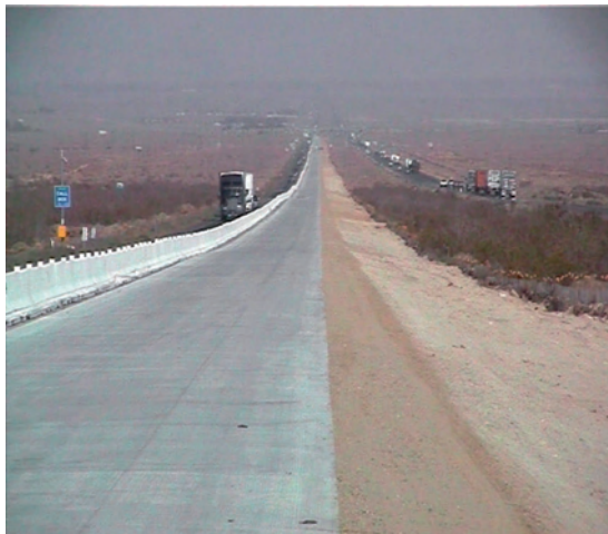
Сл. 6.1 – Коловоз од цемент бетона
