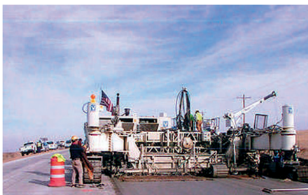
Сл. 6.12 – Претходно уграђене бетонске траке као оплата
