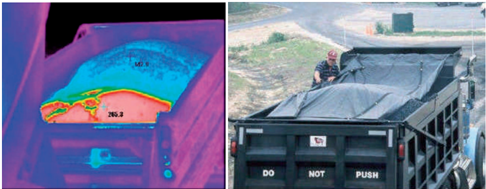
Сл. 5.21 – Заштита асфалтне масе од брзог хлађења
