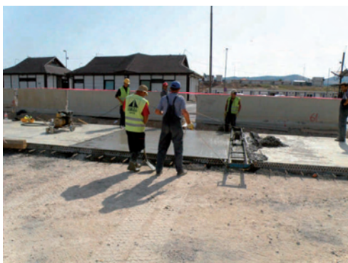
Сл. 6.21 – Вибрациона летва код ручног уграђивања бетона
