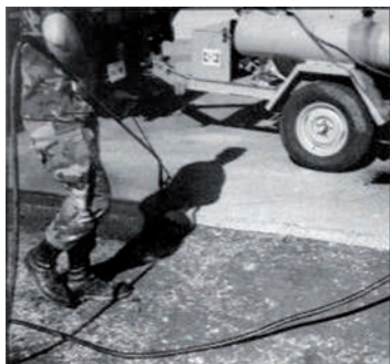
г) Прскање ивица пукотине емулзијом
