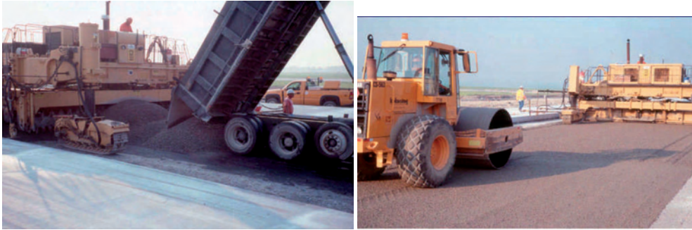
Сл. 5.48 – Израда стабилизације са финишерима за бетон
