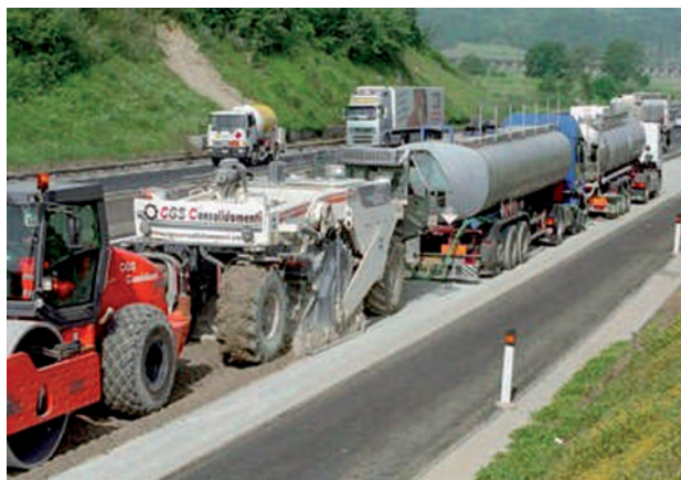
Сл. 5.4 – Извођење рециклаже по хладном поступку уз додатак цемента
