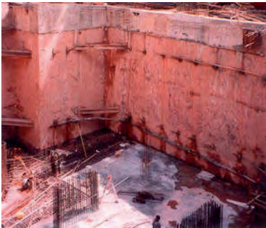
Сл. 2.5 – Контакт анкера и косине ископа, (у земљаној и каменитој подлози)
