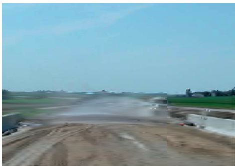
Сл. 6.17 – Пре бетонирања треба положити фолију или попрскати подлогу да не би дошло до појаве пукотина у бетону
