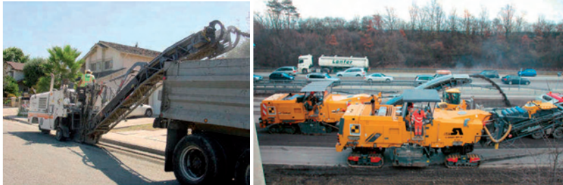
Сл. 3.1 – Профилисање асфалтног коловоза
