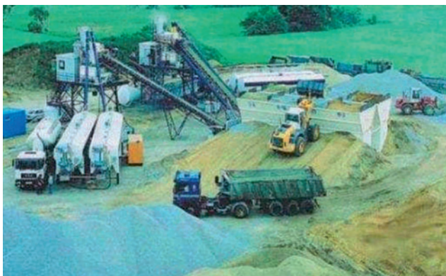
Сл. 6.10 – Производња бетона
