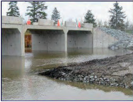
Сл. 2.21 – Косина насипа обложена каменом на прилазу мосту
