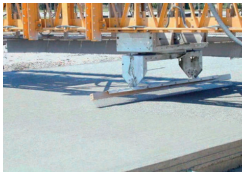
Сл. 6.22 – Охрапављивање површине
