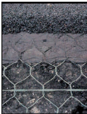
Сл. 4.20 – Челична арматурна мрежа
