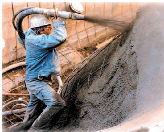
Сл. 2.11 – Прскани бетон – торкрет
