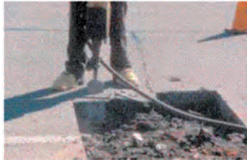
Сл. 4.18 – Пример поправке рупе у коловозној конструкцији
