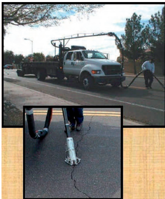
Сл. 4.6 – Чишћење коловоза усисавањем
