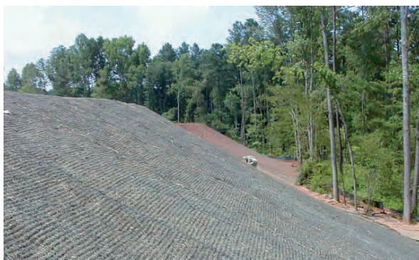
Сл. 2.17 – Непосредно пре затрављивања косине насипа
