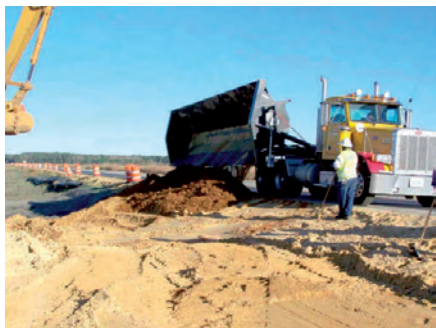
Сл. 7.8 – Изградња банке, насипање
