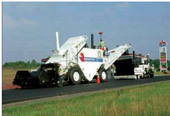
Сл. 5.30 – Машина за претходно мешање асфалтне масе, (између камиона и финишера)
