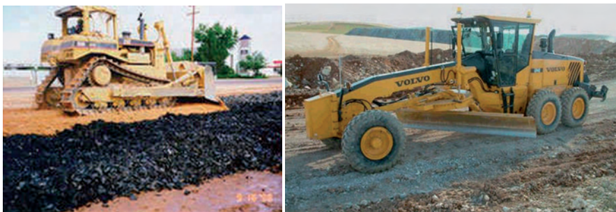
Сл. 1.18 – Разастирање и планирање материјала за насип
