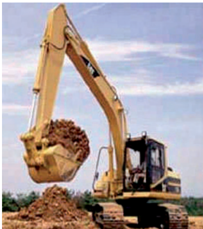
Сл. 1.29 – Замена слабо носивог материјала
