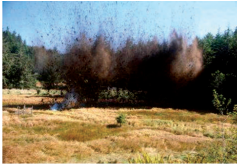
Сл. 1.5 – Ископ помоћу експлозива
