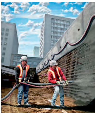
Сл. 2.10 – Арматурна мрежа
