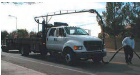
Сл. 4.9 – Компресор за издување топлог ваздуха
