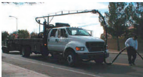
в) Чишћење ивица компримованим ваздухом
