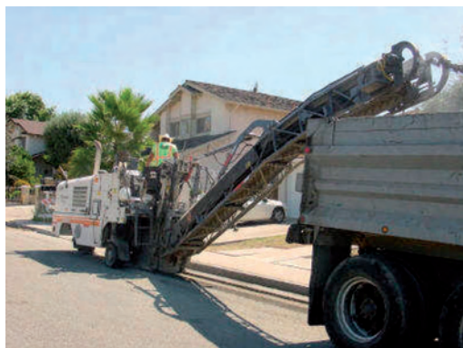
а) Грebaње оштећене површине
