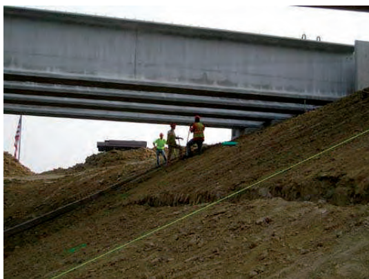
Сл. 2.16 – Затрављивање косине насипа
