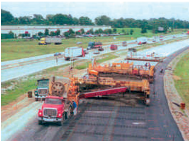
Сл. 6.20 – Уграђивање бетона
