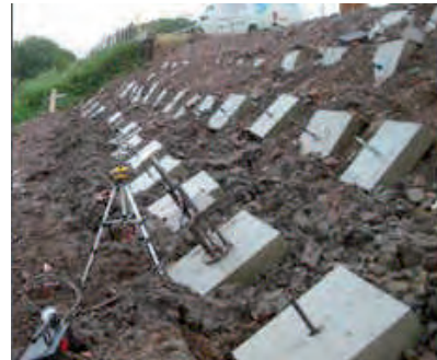
Сл. 2.5 – Контакт анкера и косине ископа, (у земљаној и каменитој подлози)
