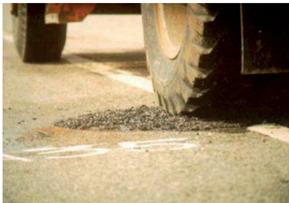
Слика 3.24 Поступак “баци и изваљај” - збијање закрпе
