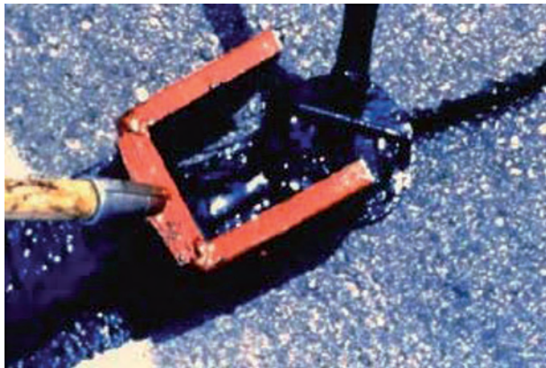
Слика 3.18 Модла у облику "U" за уклањање вишка материјала
