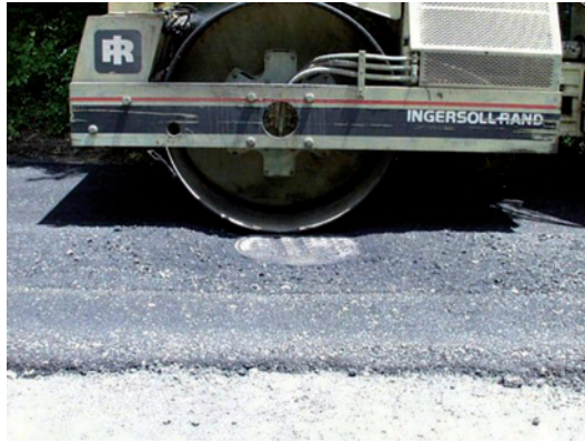
Слика 3.76 Обрада закрпе око шахта
