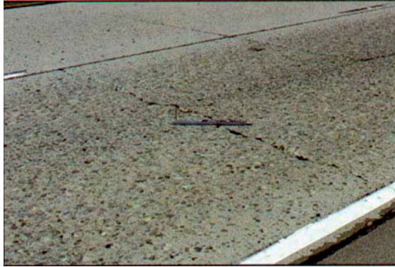
Слика 4.14 Попречна пукотина великог нивоа оштећености
