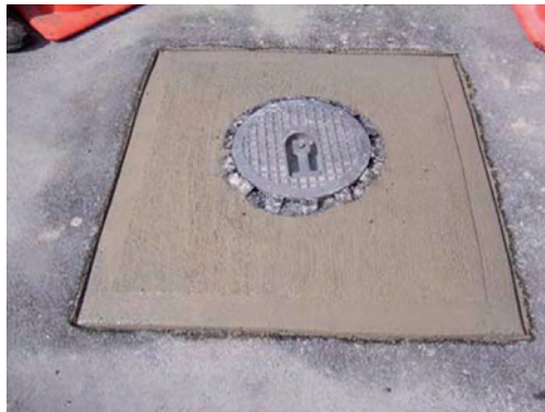
Слика 3.77 Поправка око шахтова
