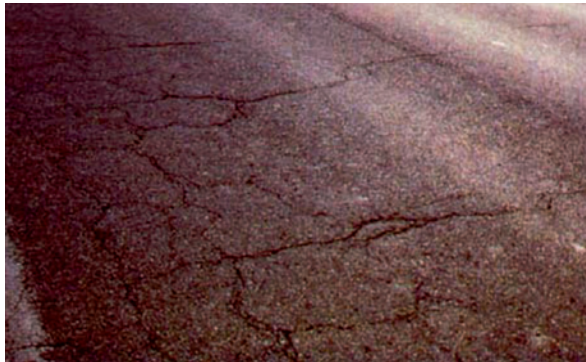
Слика 2.25 Велика оштећеност са пукотинама у облику блокова
