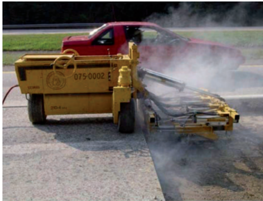
Слика 5.30 Машинско бушење рупа за можданике
