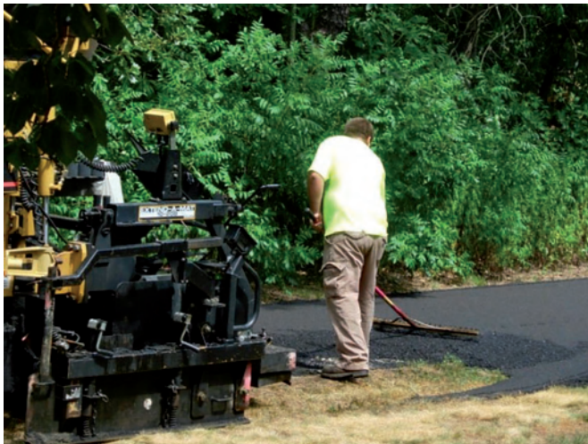
Слика 3.34 Равнање разастрте асфалтне мешавине
