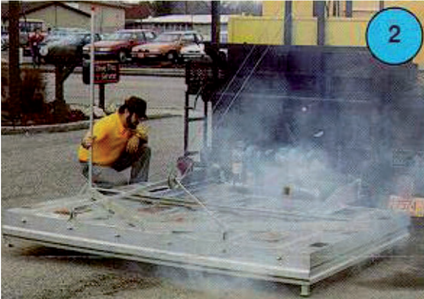
Слика 3.58 Топлота из инфрацрвеног грејача продире у асфалтни слој око 5cm
