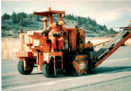
Слика 3.26 Полу - стални поступак (опсецање ивица рупе машином за глодање по хладном поступку)
