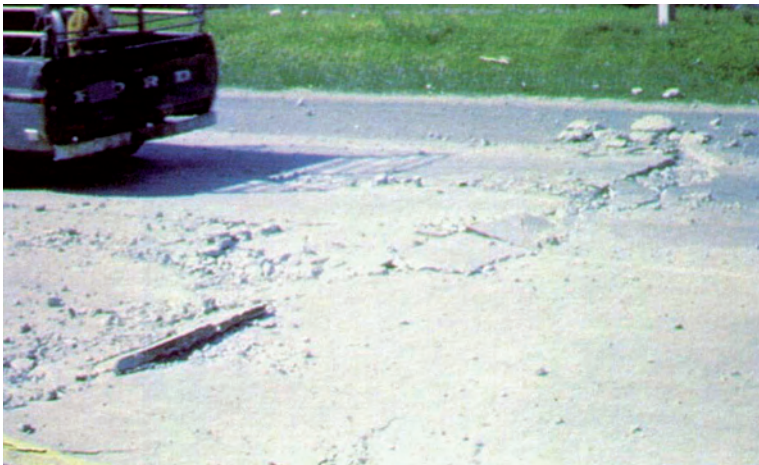
Слика 4.30 Експлозија – издизање при великом нивоу оштећености
