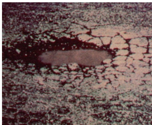
Слика 2.47 Деталъ рупе великог нивоа оштећености
