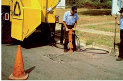
Слика 3.41 Опсецање ивица оштећене површине пикхамером
