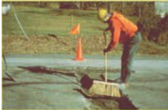
Слика 3.45 Чишћење опсеченог места метлом
