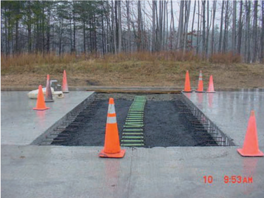
Слика 5.21 Положај елемената за везу - можданика, при замени делова плоча
