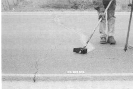
Слика 3.17 Модла у облику "U" за уклањање вишка материјала
