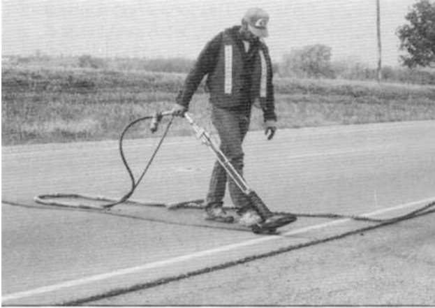
Слика 3.10 Обеспрашивање са загрејаним ваздухом
