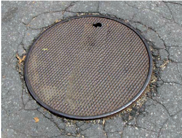
Слика 3.74 Оштећење око шахта
