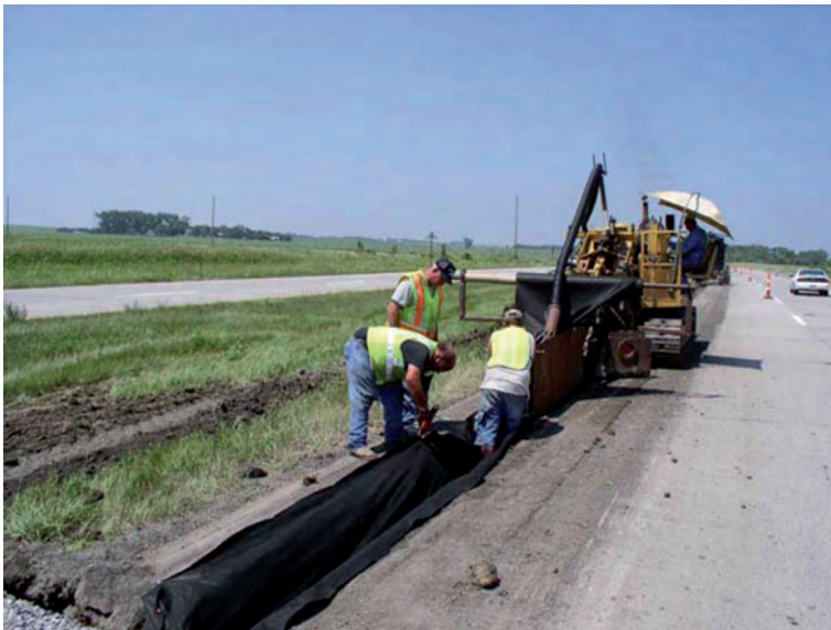
Слика 3.79 Причвршћивање филтерске тканине за ивице рова
