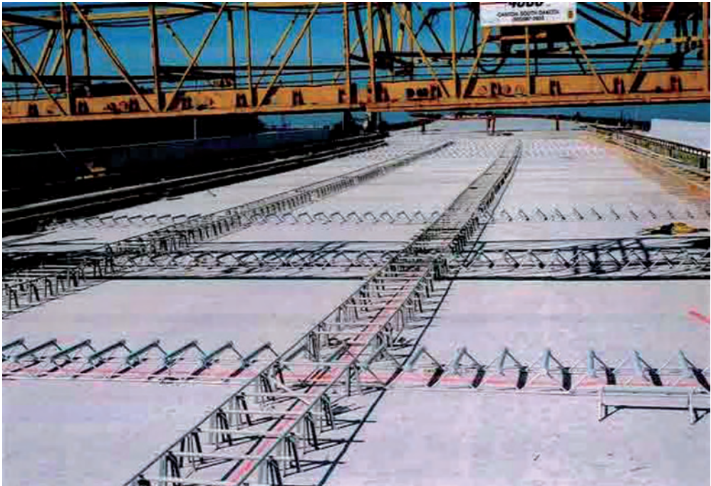
Слика 1.10 Неармирана бетонска плоча са можданицима у попречним спојницама
