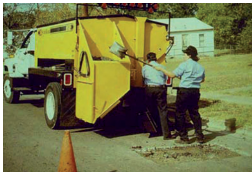
Слика 3.43 Уклањање оштећеног материјала (грубо чишћење)
