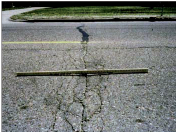
Слика 2.38 Попречна пукотина
