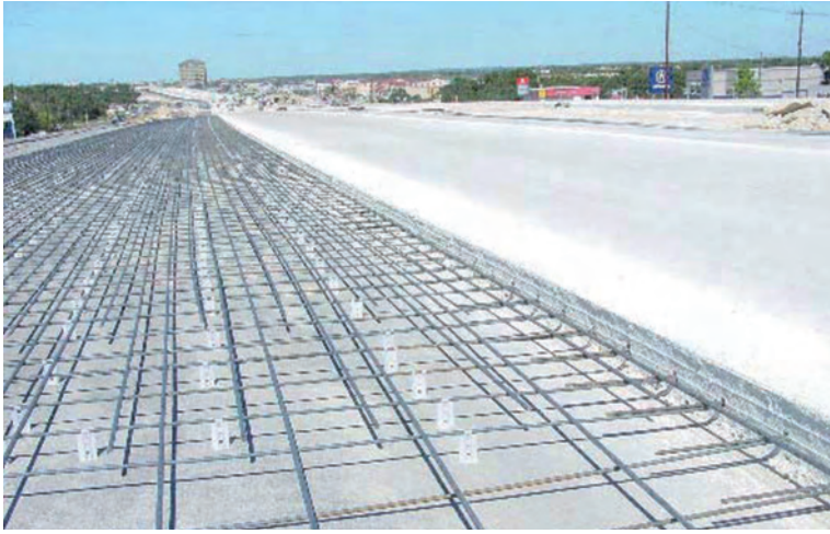
Слика 1.12 Армирана бетонска плоча
