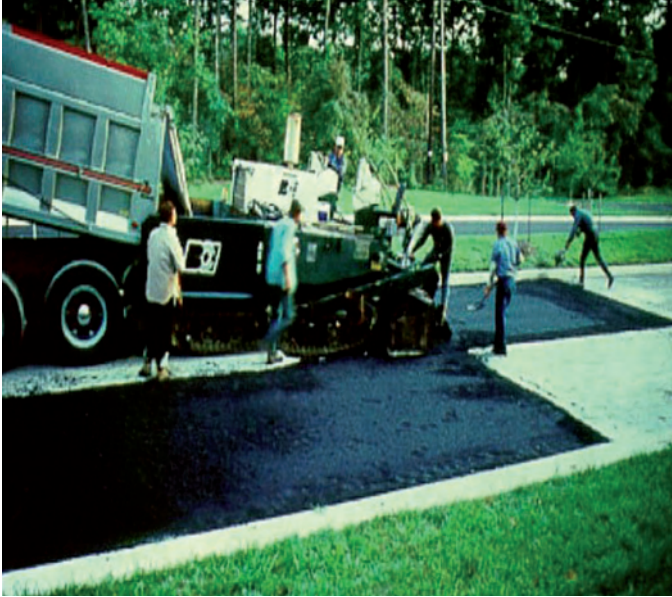
Слика 3.55 Опрема за поправку рупа
