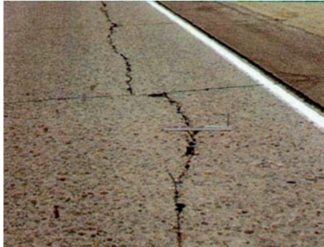
Слика 4.11 Подужне пукотине великог нивоа оштећености
