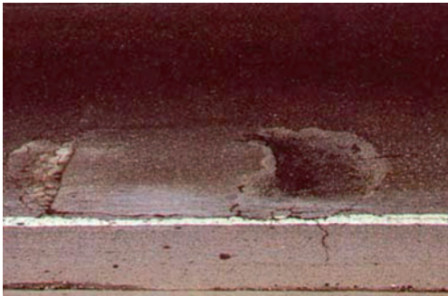
Слика 2.41 Средњи ниво оштећености закрпе
