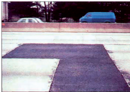
Слика 4.39 Велика закрпа са асфалт бетоном малог нивоа оштећености
