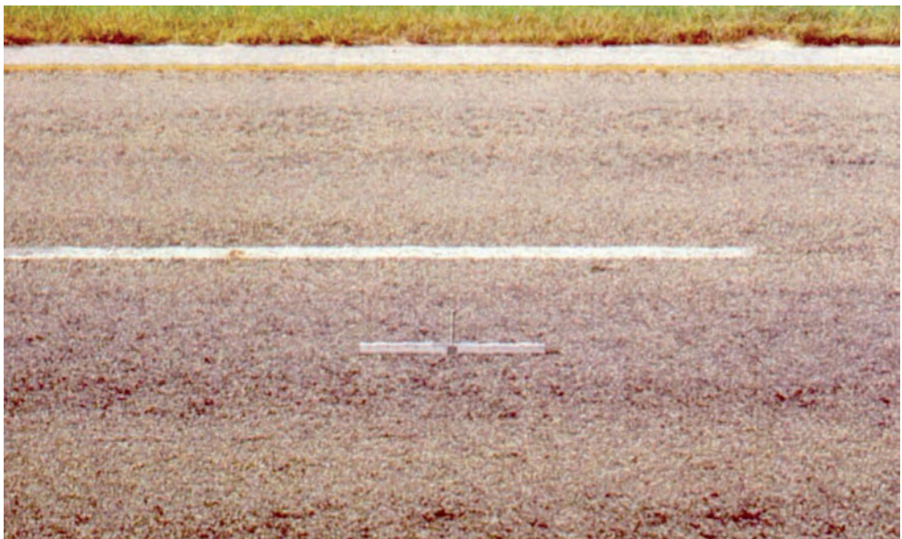
Слика 2.54 Излучевине при малом нивоу оштећености
