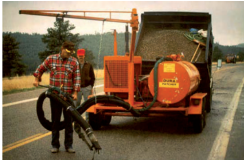
Слика 3.29 Опрема за распршивање - инјектирање (камион са приколицом)
