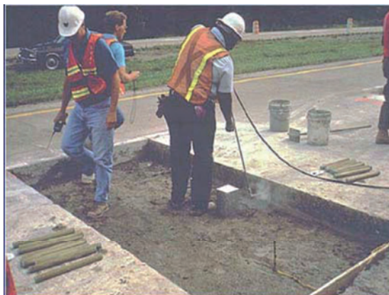
Слика 5.31 Чишћење рупа за можданике компримованим ваздухом
