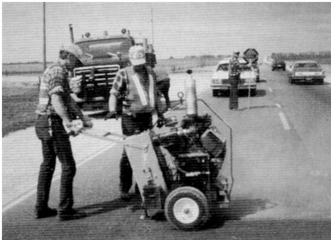
Слика 3.5 Тестера са дијамантским сечивом за пукотине
