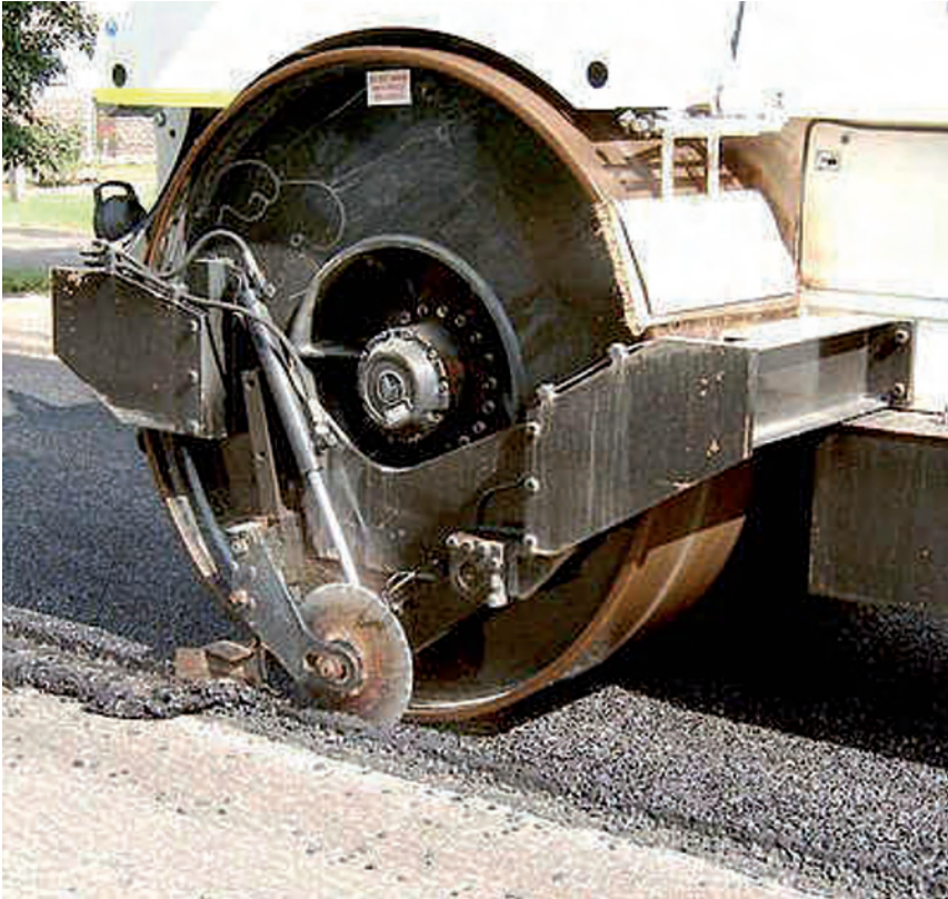
Слика 3.95 Ваљање хабајућег слоја са припремом ивице радне траке за “шлус”
