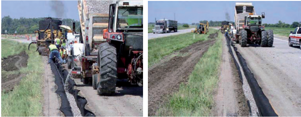
Слика 3.80 Испуњавање рова агрегатом
