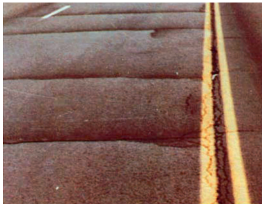
Слика 2.32 Рефлектоване пукотине при великом нивоу оштећености
