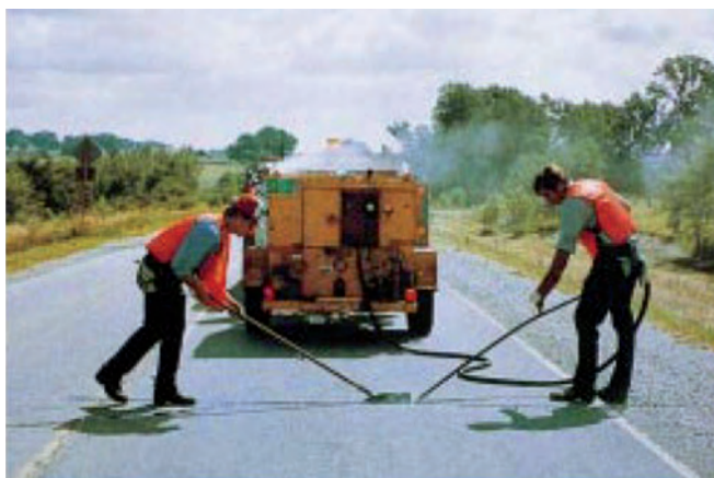
Слика 3.16 Испуна пукотине и уклањање вишка материјала
