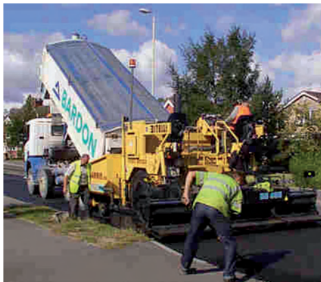
Слика 3.94 Постављање хабајућег слоја
