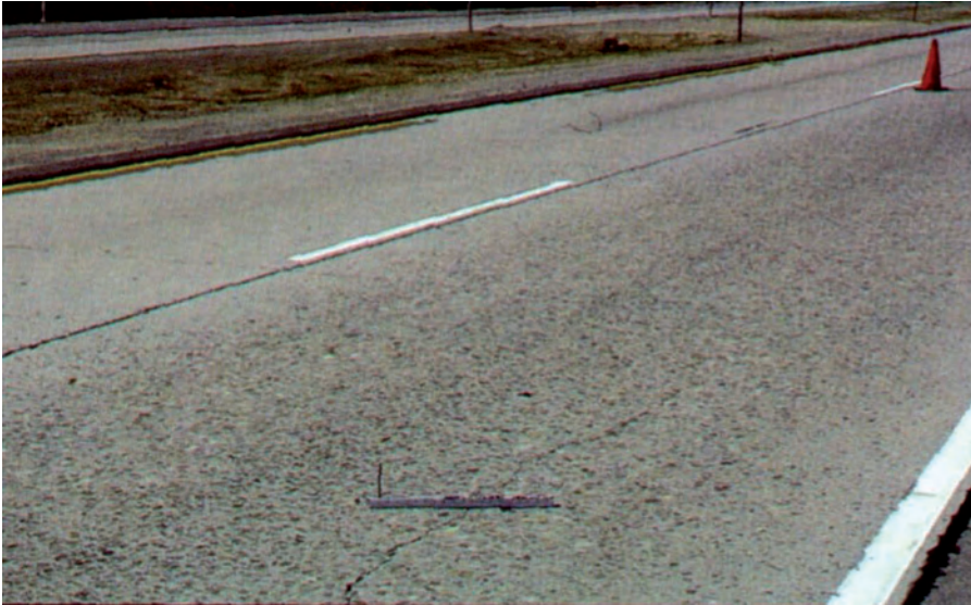
Слика 4.9 Подужне пукотине малог нивоа оштећености
