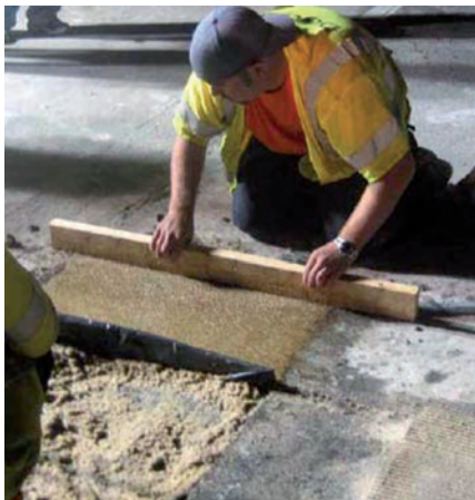
Слика 5.37 Завршетак поправке у пуној дебљини плоче
