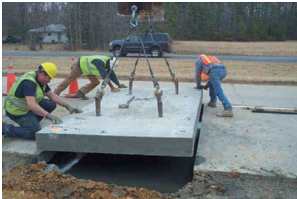
Слика 5.25 Полагање префабриковане бетонске плоче
