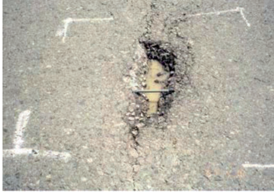
Слика 3.35 Означавање места за опсецање и поправку рупе
