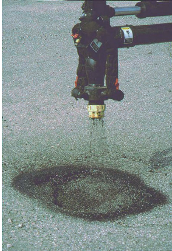
Слика 3.67 Наношење мешавине крупнозрног агрегата и емулзије
