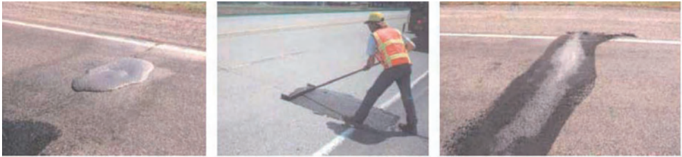
Слика 3.20 Један од могућих начина поправке пукотина (разлачењем масе)
