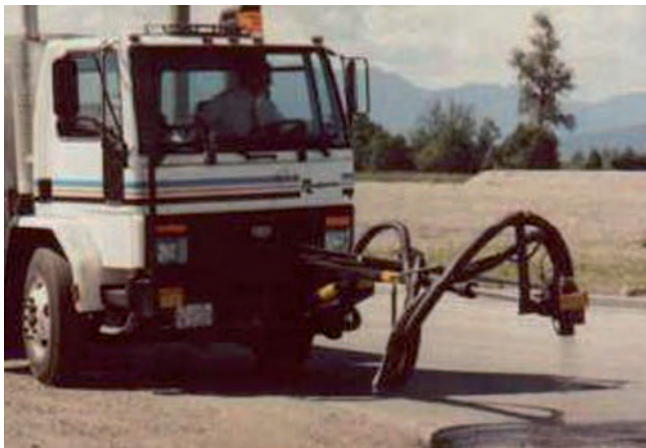
Слика 3.68 Наношење завршног слоја од ситнозрног агрегата
