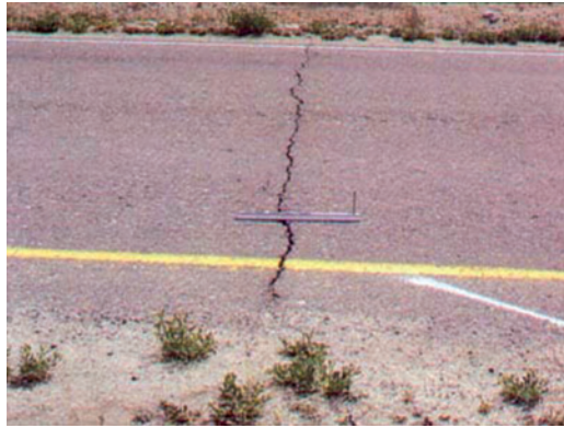
Слика 2.37 Велики ниво оштећености код попречних пукотина
