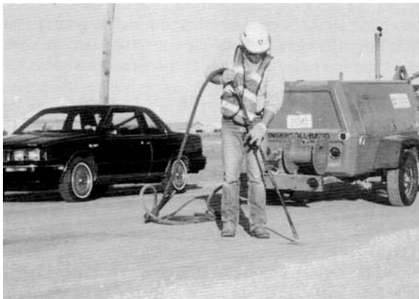
Слика 3.9 Обеспрашивање са компресором
