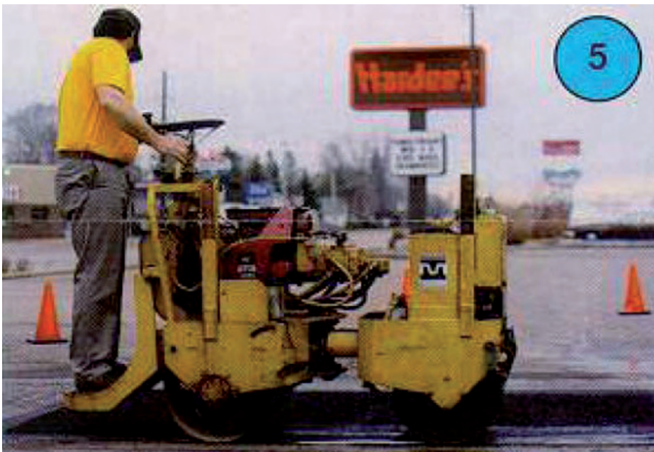
Слика 3.61 Равнање површине
