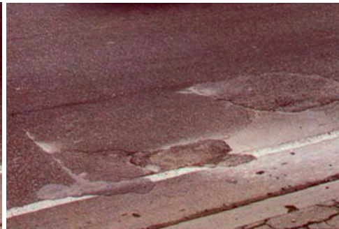
Слика 2.42 Велики ниво оштећености закрпе
