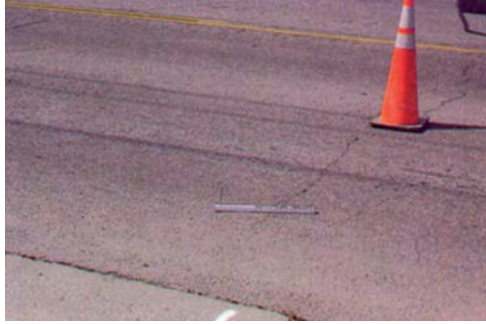
Слика 2.36 Средњи ниво оштећености код попречних пукотина
