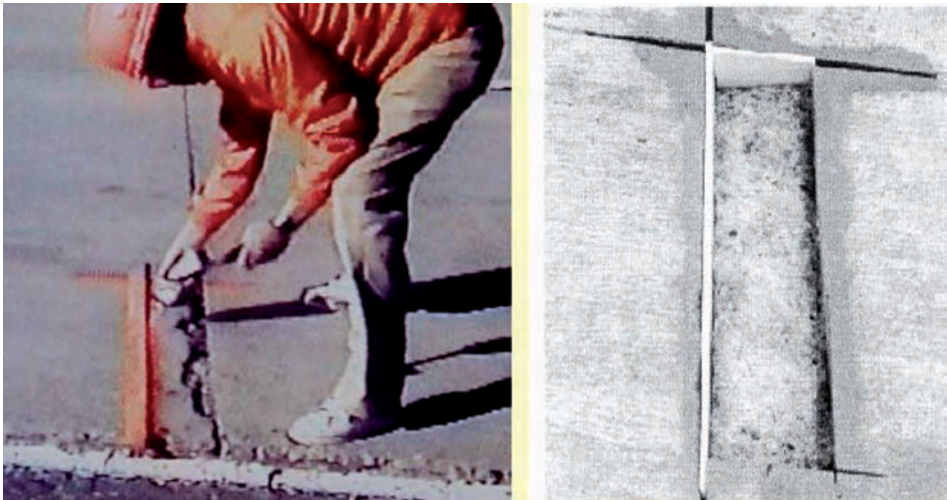
Слика 5.41 Поправка ољуспаног бетона
