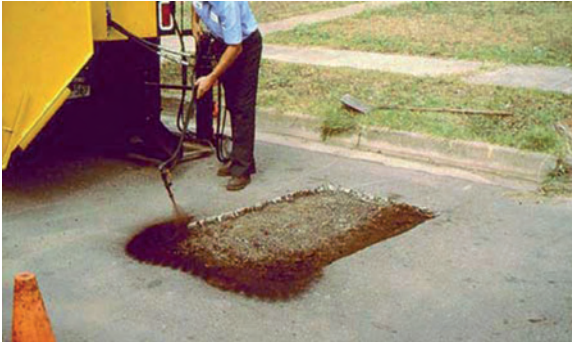
Слика 3.46 Наношење емулзије спрејом
