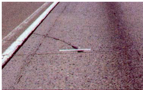
Слика 4.4 Средњи ниво оштећености угаоне пукотине
