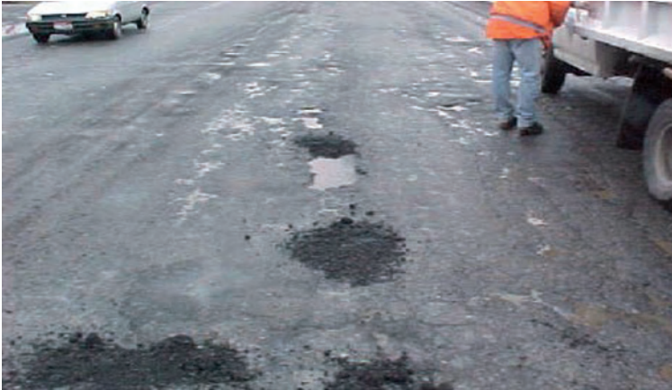
Слика 3.22 Специјални материјали који вежу и у води
