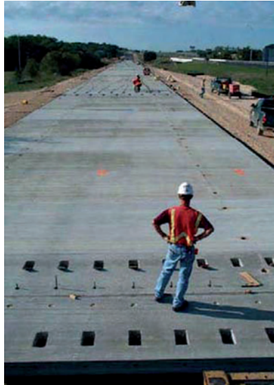
Слика 1.17 Преднапрегнута бетонска плоча
