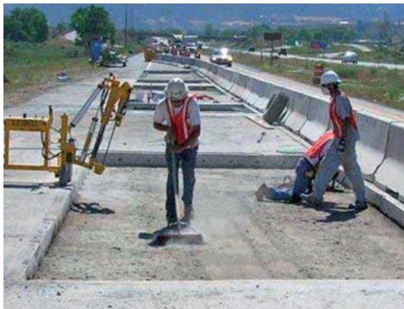
Слика 5.32 Чишћење подлоге за постављање новог бетона
