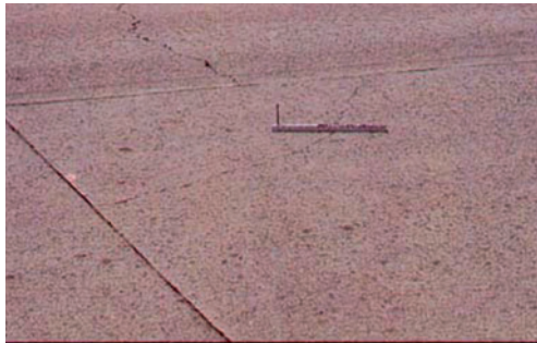
Слика 4.3 Низак ниво оштећености угаоне пукотине
