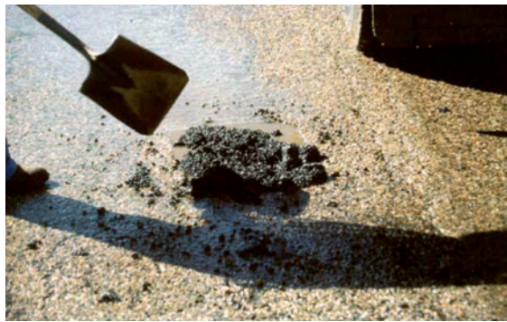
Слика 3.23 Поступак “баци и изваљај” - постављање материјала
