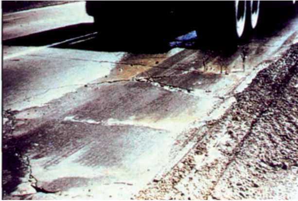
Слика 4.38 Цурење и пумпање воде
