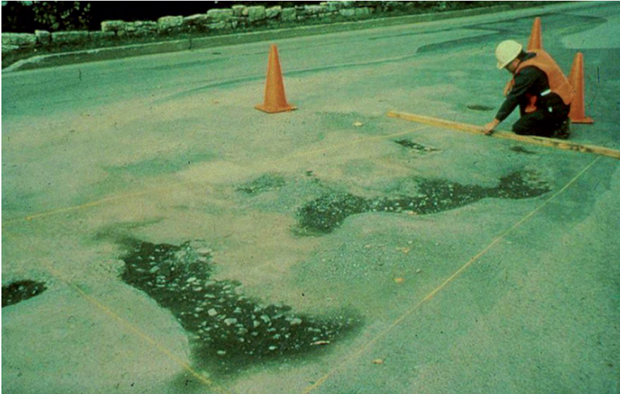
Слика 2.48 Детаљ обележавања површине са рупама великог нивоа оштећености
