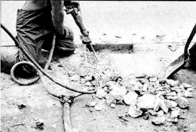
Слика 5.9 Обрада оштећене површине (неповољан положај радника са становишта ергономије)
