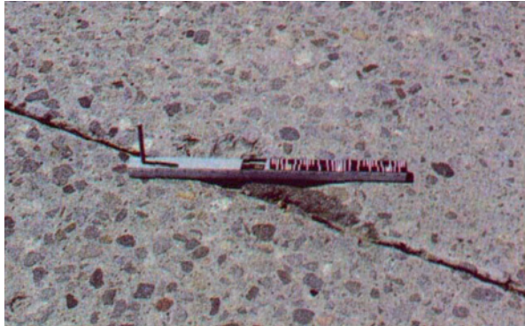
Слика 4.22 Детаљ окруњене попречне спојнице средњег нивоа оштећености
