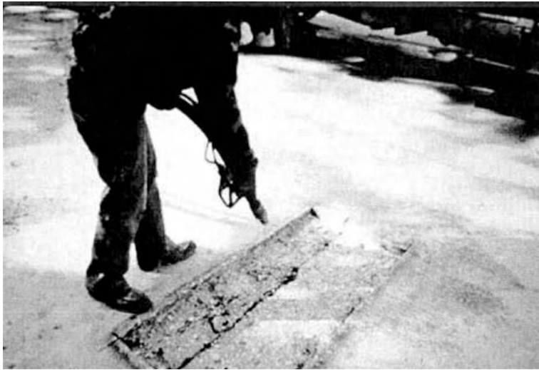
Слика 5.11 Чишћење површине пескарењем
