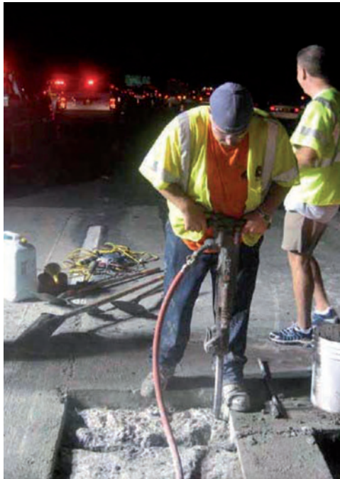
Слика 5.10 Обрада оштећене површине (повољан положај радника)
