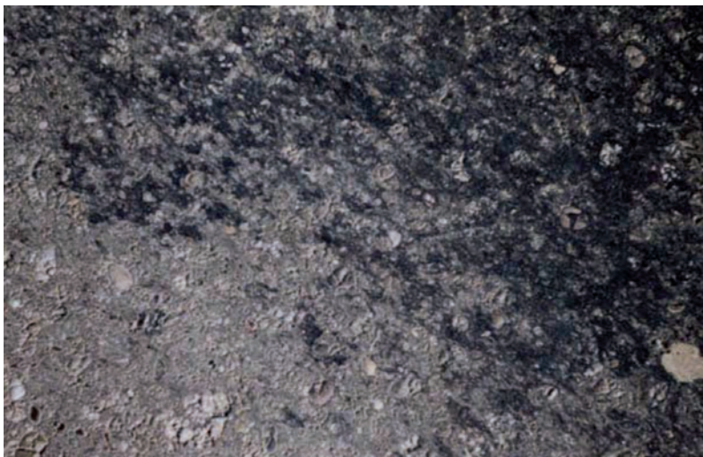
Слика 2.55 Излучевине при средњем нивоу оштећености
