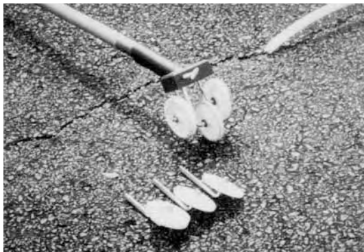
Слика 3.12 Алат за уметање траке против везивања
