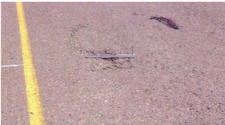
Слика 2.44 Рупе малог нивоа оштећености
