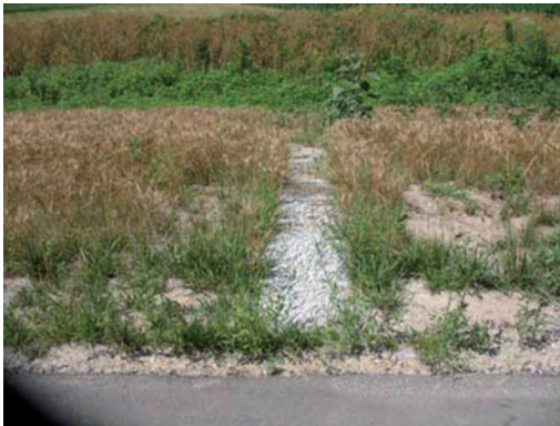
Слика 3.81 Одводни цевовод
