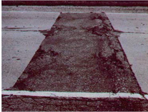
Слика 4.40 Велика закрпа са асфалт бетоном великог нивоа оштећености
