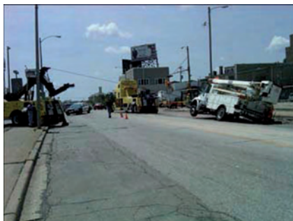
Слика 3.85 Пролом коловозне конструкције
