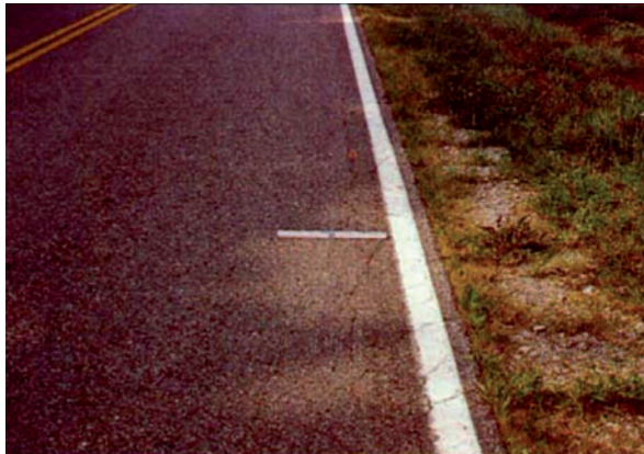
Слика 2.27 Мали ниво оштећености површине захваћене ивичним пукотинама
