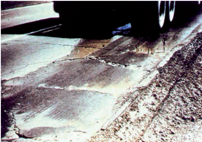
Слика 4.42 Цурење и пумпање воде
