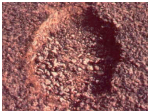
Слика 2.46 Деталъ рупе средњег нивоа оштећености
