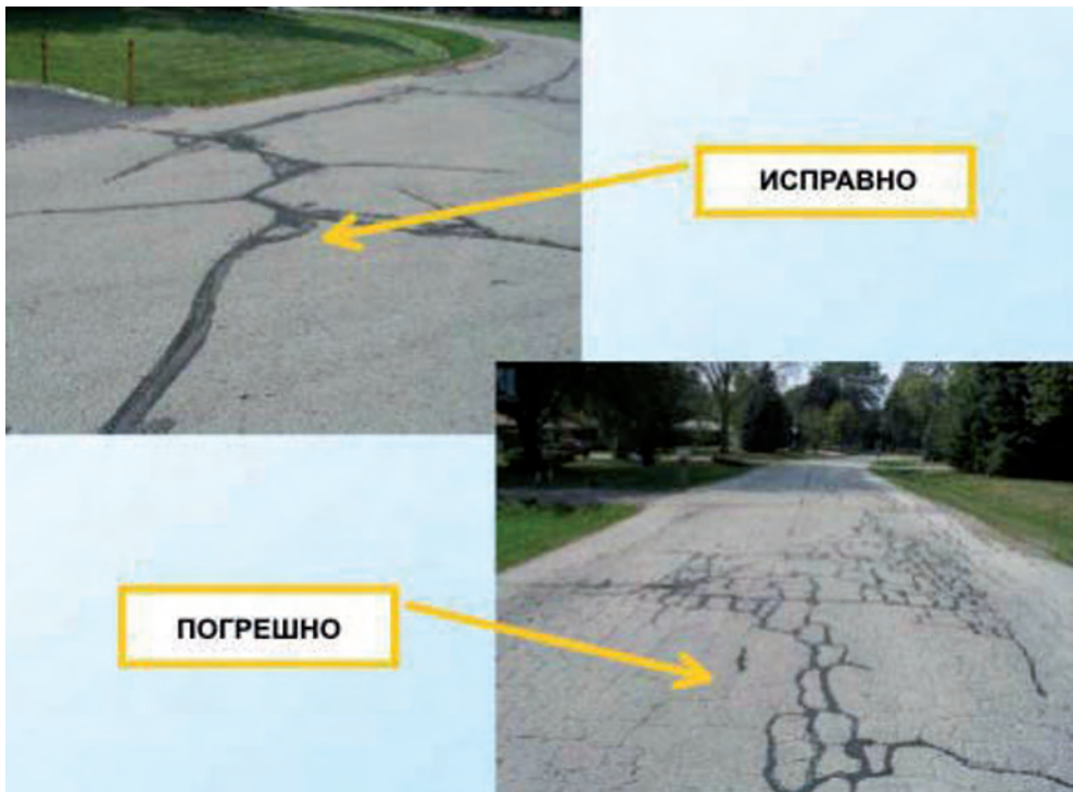
Слика 3.21 Исправно и погрешно заливање пукотина
