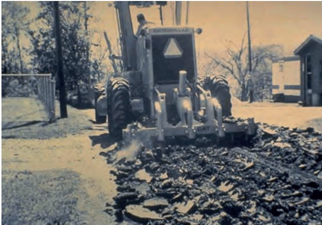
Слика 3.86 Ломљење постојећих оштећених слојева
