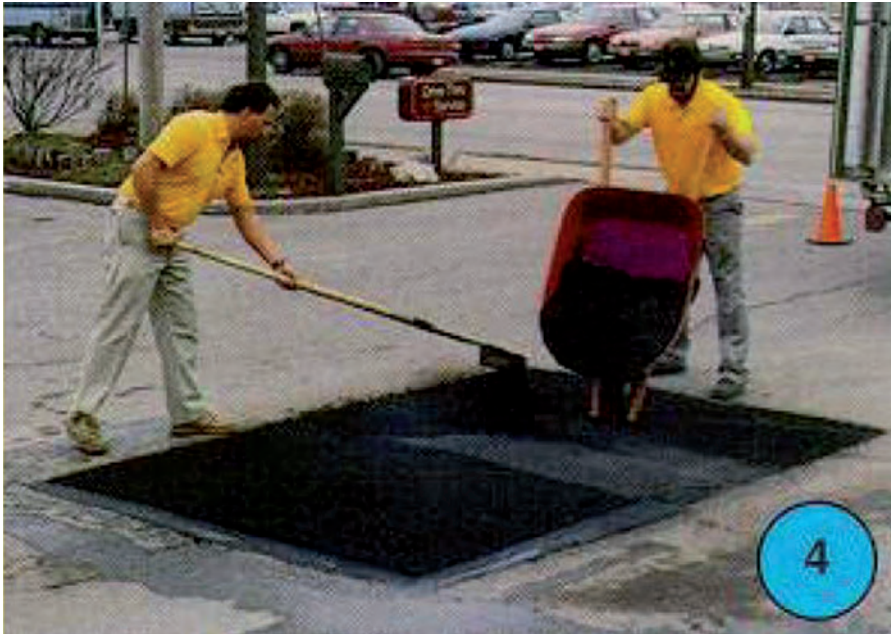
Слика 3.60 Додавање новог асфалта и мешање са постојећим
