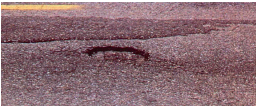
Слика 2.45 Рупе средњег нивоа оштећености
