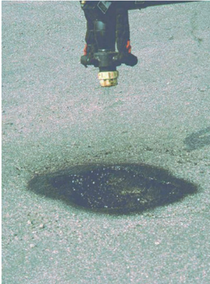
Слика 3.66 Прскање емулзијом
