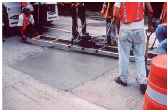
Слика 5.33 Вибрирање уграђеног бетона
