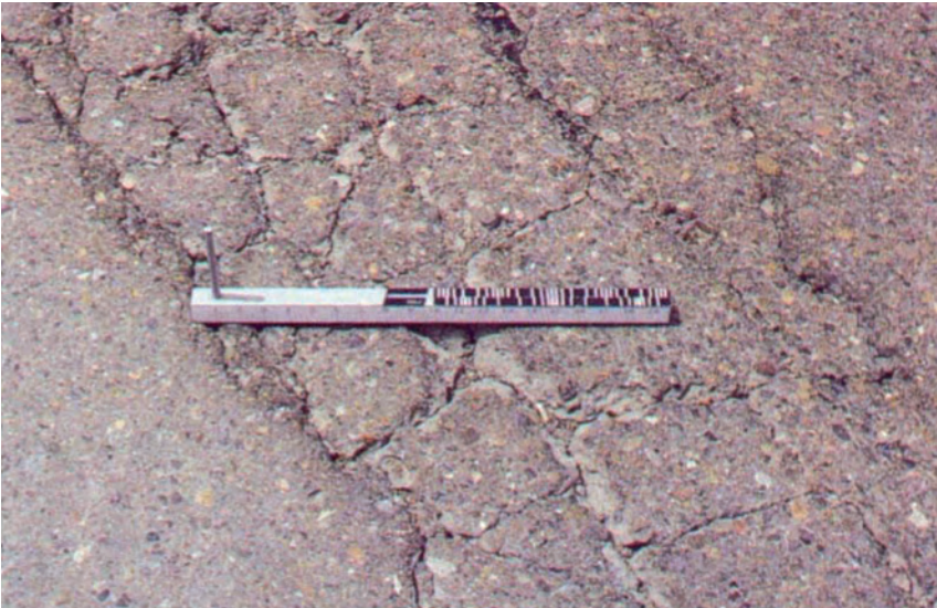
Слика 2.22 Изглед великог нивоа оштећености код пукотина насталих од замора. Ивице пукотина су окруњене
