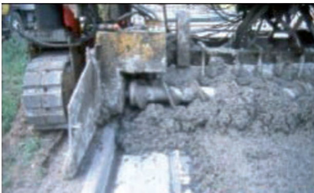
Слика 5.44 Изливање ригола
