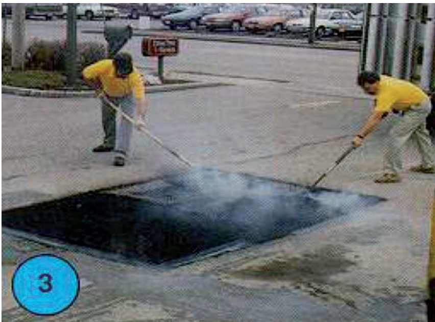
Слика 3.59 Разгрејани асфалт се грабуљама поравна и очисти од непожељних материја
