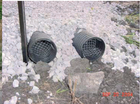
Слика 3.82 Испусти из дренажних цеви
