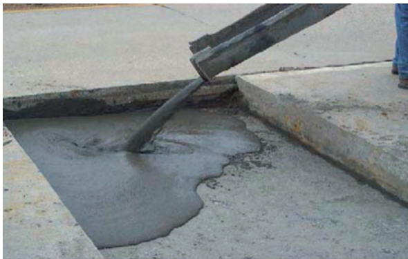
Слика 5.24 Изравнавајући слој
