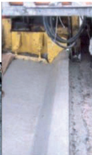
Слика 5.45 Равнање ригола
