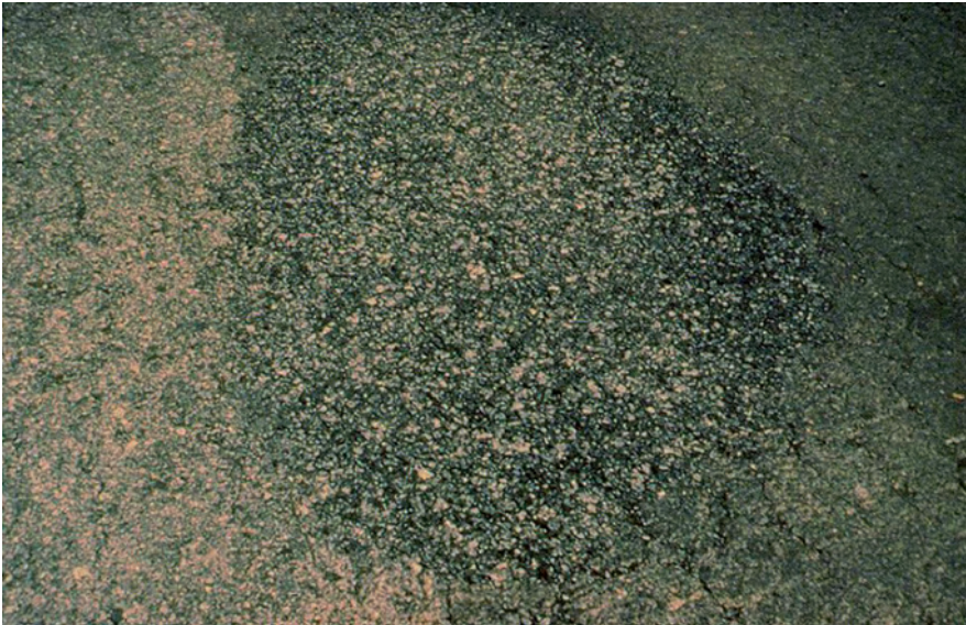
Слика 3.70 Изглед завршене закрпе
