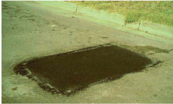
Слика 3.53 Изглед готове закрпе
