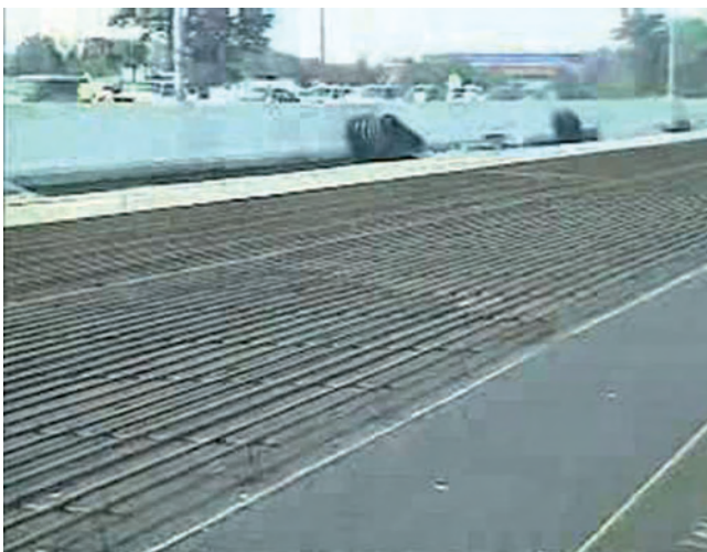
Слика 1.14 Непрекидно армирана бетонска плоча
