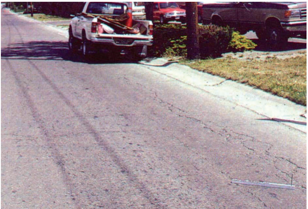
Слика 2.20 Изглед средњег нивоа оштећености код пукотина насталих услед замора коловозне површине
