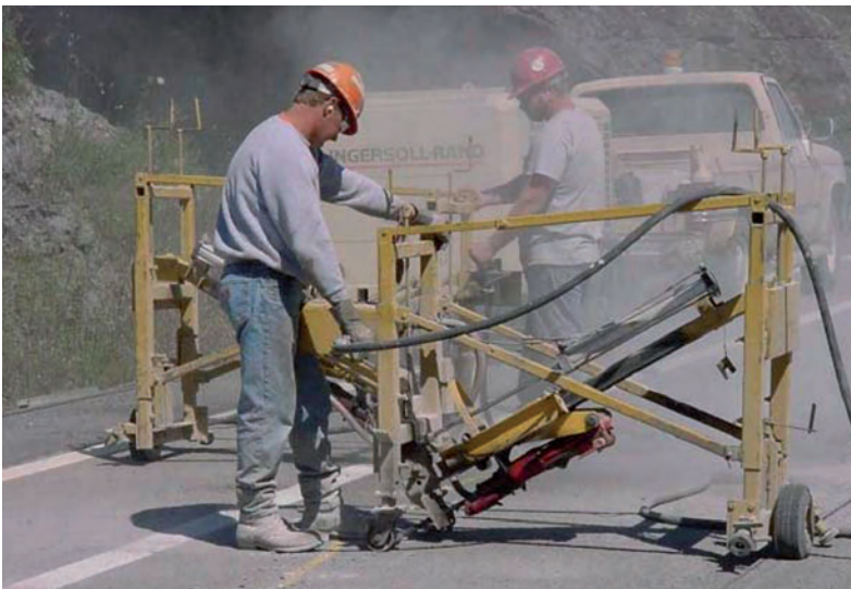
Слика 5.2 Повезивање пуклих плоча унакрсним копчама
