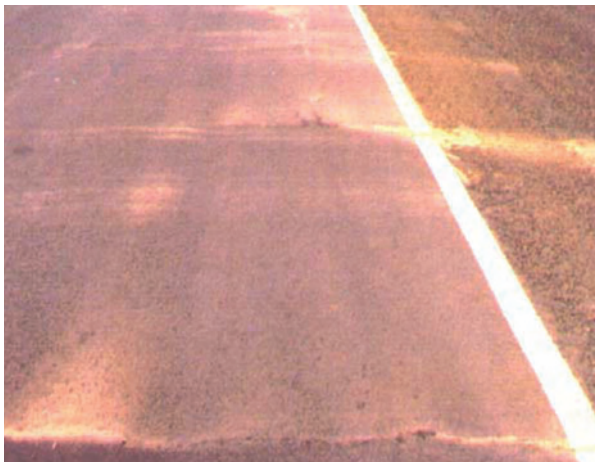
Слика 2.64 Фин материјал избачен цурењем и пумпањем воде
