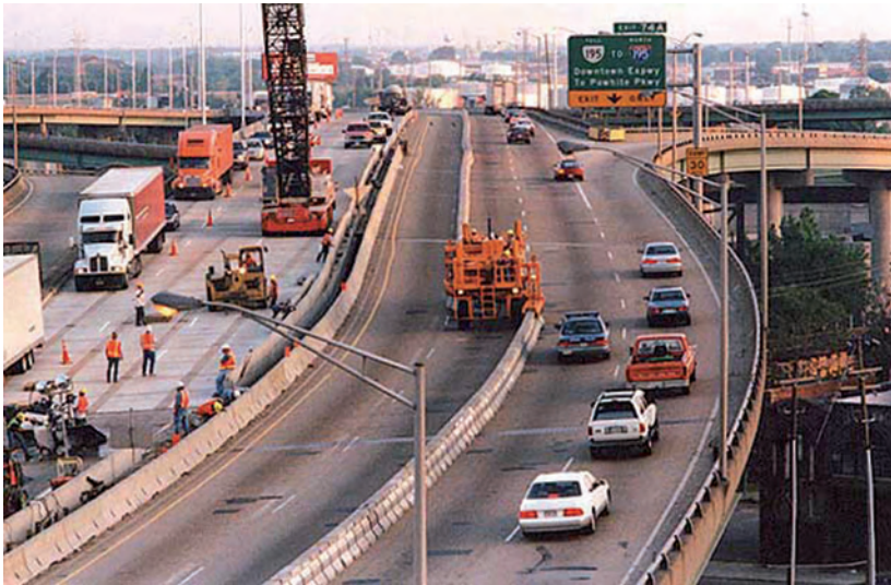
Слика 6.22 Машина за премештање “њу џерси” елемената, “зипер”
