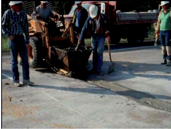
Слика 5.35 Испуна бетоном просеченог жлеба у бетонској плочи
