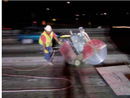
Слика 3.42 Опсецање пукотина тестером
