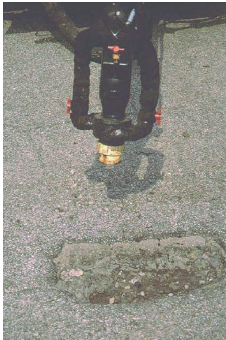
Слика 3.65 Поступак издувавања рупе – чишћења
