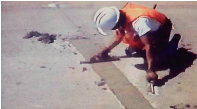
Слика 5.36 Глачање поправљене ивице бетонске плоче
