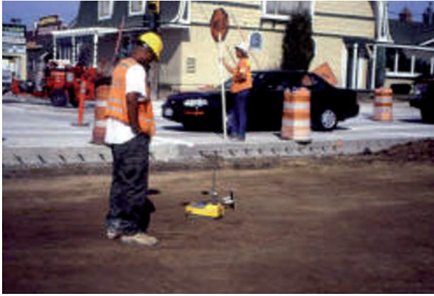
Слика 3.91 Поправка постељице – испитивање квалитета изведеног слоја
