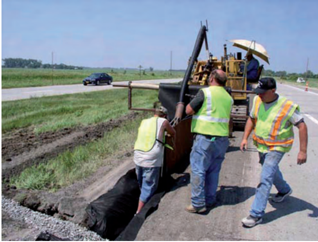
Слика 3.78 Полагање дренажне цеви
