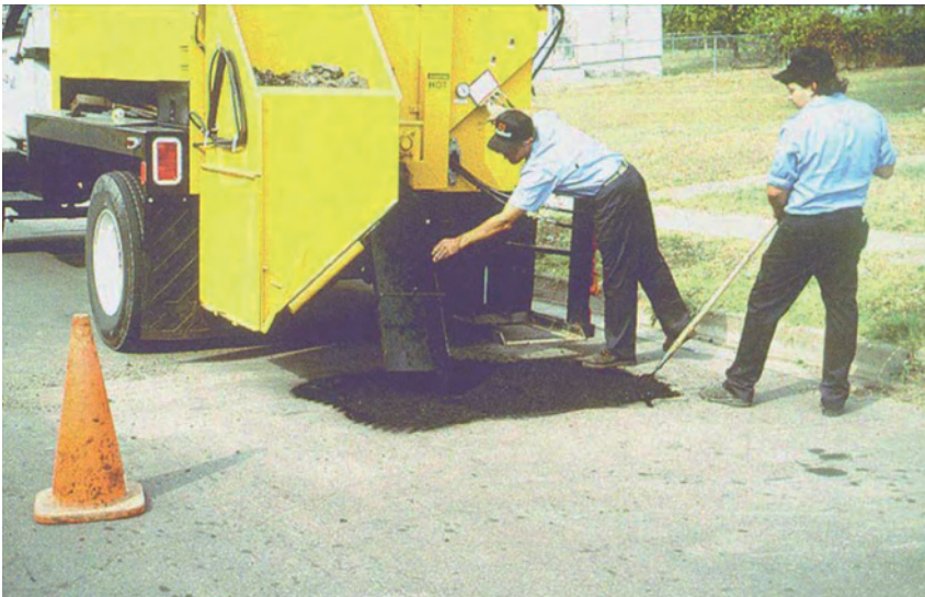
Слика 3.48 Наношење асфалтне масе
