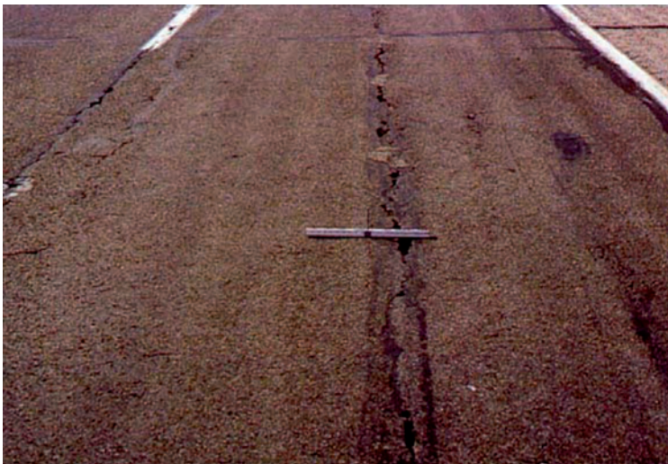
Слика 2.30 Подужне пукотине изван трагова точкова при великом нивоу оштећености
