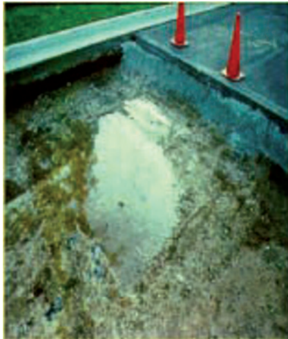
Слика 3.90 Уконили воду са постељице
