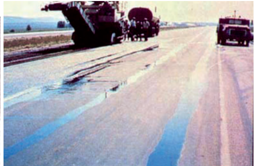
Слика 2.59 Чупање зрна агрегата при средњем нивоу оштећености
