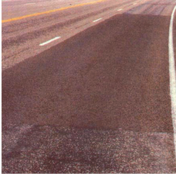
Слика 2.40 Мали ниво оштећености закрпе
