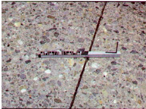
Слика 4.15 Испуна спојнице малог нивоа оштећености
