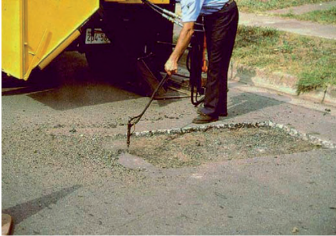
Слика 3.44 Уклањање заосталог материјала после грубог чишћења издувавањем
