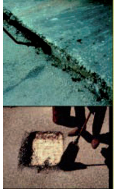
Слика 3.47 Наношење емулзије спрејом и метлом
