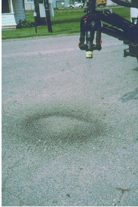
Слика 3.69 Наношење завршног слоја од ситнозрног агрегата
