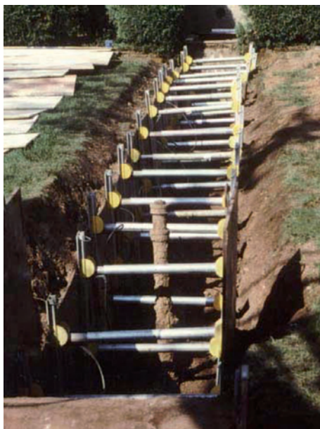
Слика 6.2 Приказ оплате при постављању водоводне мреже
