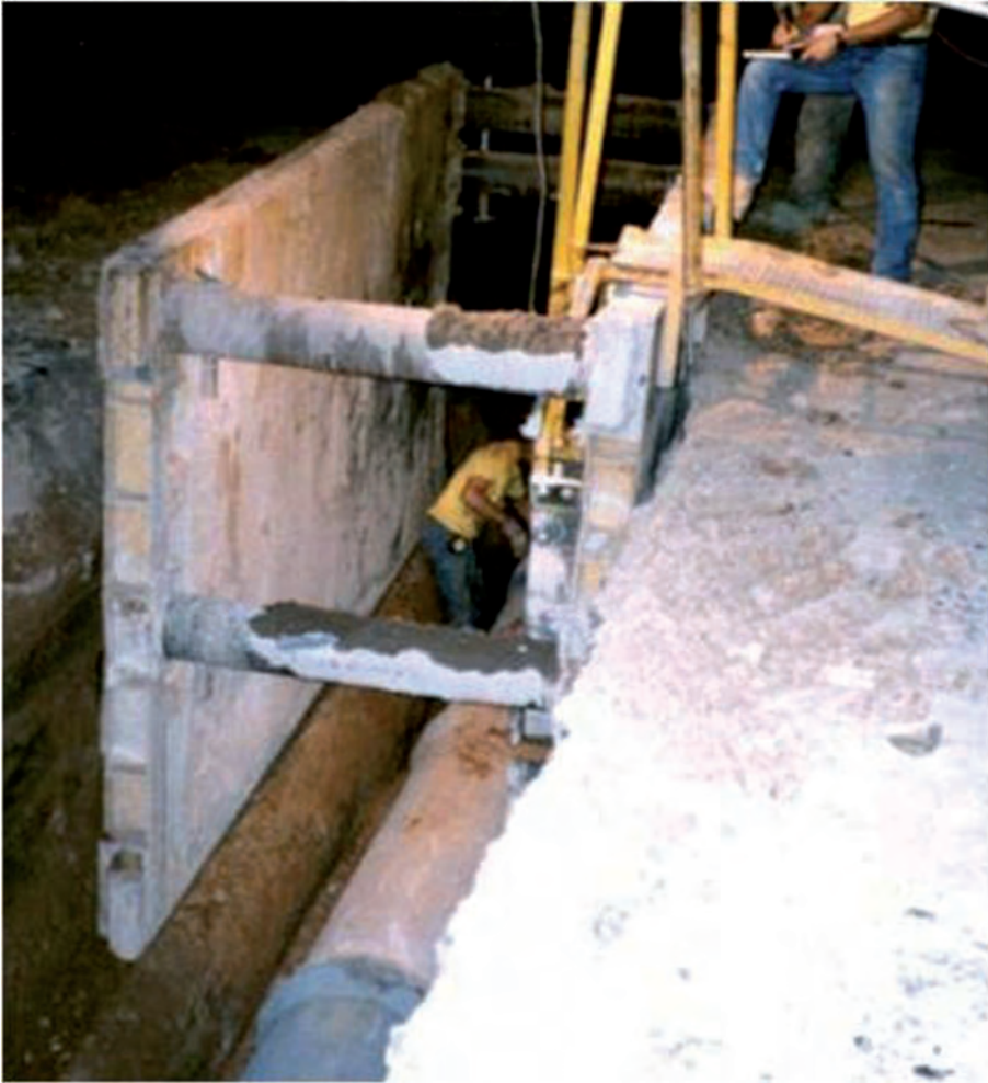
Слика 6.3 Приказ оплате при постављању водоводне мреже
