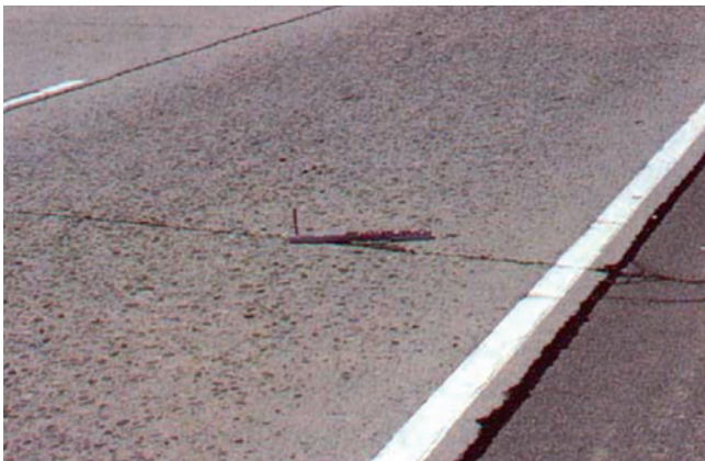
Слика 4.21 Окруњене попречне спојнице средњег нивоа оштећености
