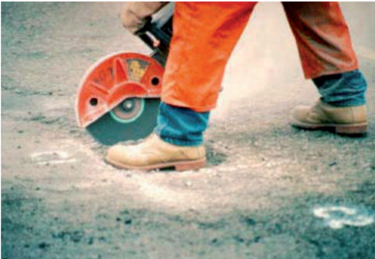
Слика 3.25 Полу - стални поступак (опсецање ивица рупе ручном тестером)
