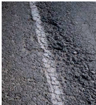
Слика 2.60 Чупање зрна агрегата при великом нивоу оштећености
