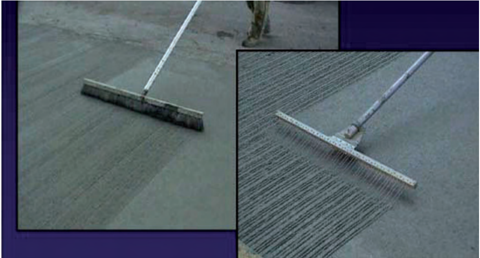
Слика 5.40 Завршно охрапављивање
