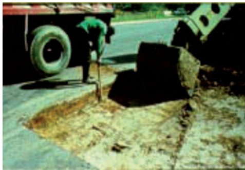
Слика 3.87 Уклањање оштећених слојева
