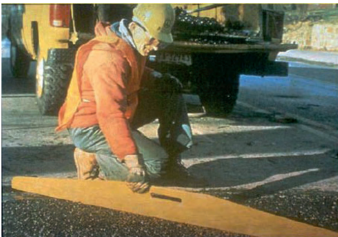
Слика 3.54 Контрола равности извршене закрпе
