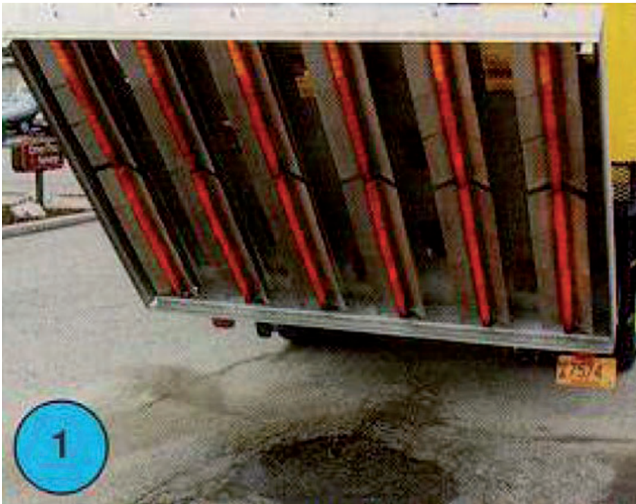
Слика 3.57 Инфрацрвени грејач се поставља на 15 см изнад асфалтног застора
