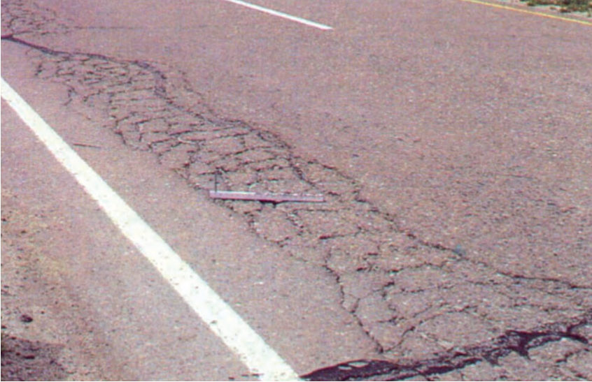
Слика 2.21 Изглед великог нивоа оштећености код пукотина од замора
