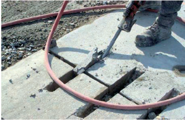
Слика 5.26 Убацавање можданика (да би се везале плоче)
