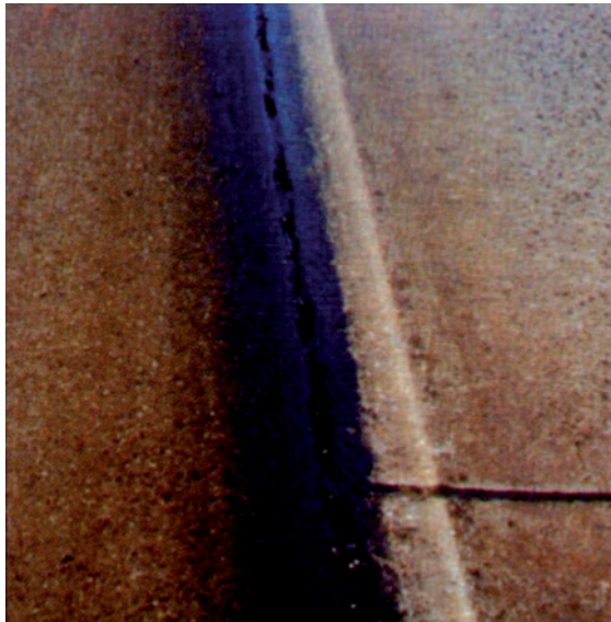
Слика 4.36 Лоше испуњен расцеп
