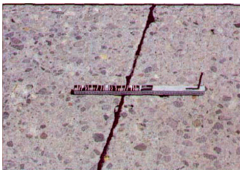
Слика 4.16 Испуна спојнице средњег нивоа оштећености
