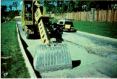
Слика 3.88 Ископ и уклањање оштећених слојева
