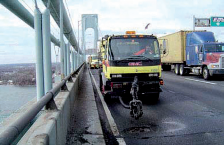
Слика 3.64 Поступак издувавања рупе – чишћења
