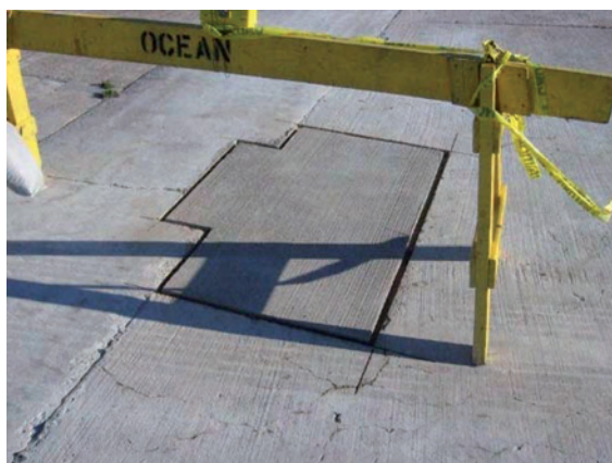
Слика 5.34 Изглед поправљене бетонске плоче
