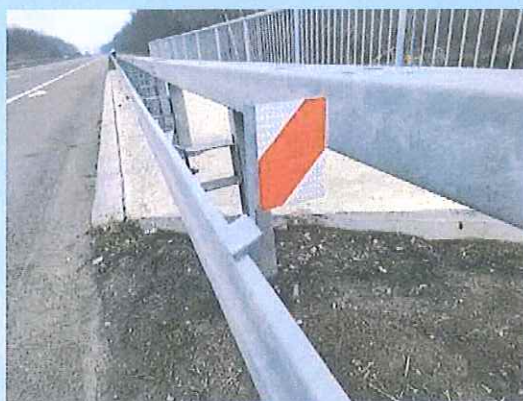
Слика 8 – Индикатор за означавање путног објекта и зона издигнутих ивичњака на челичној заштитној огради
