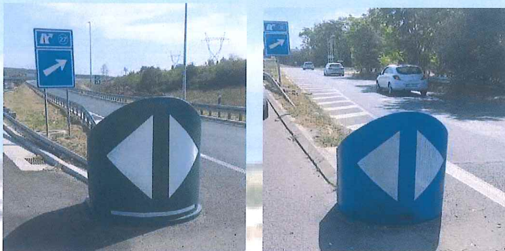
Слика 13 – Постављање индикатора врха површине раздвајања токова
