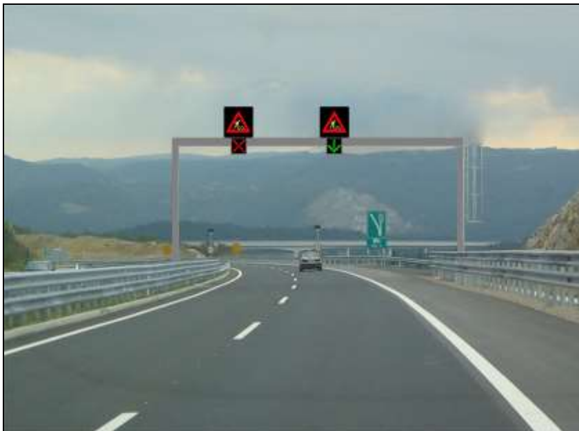
Slika 6.6.3: Simbolična slika promenljive linijske signalizacije (PLS)
