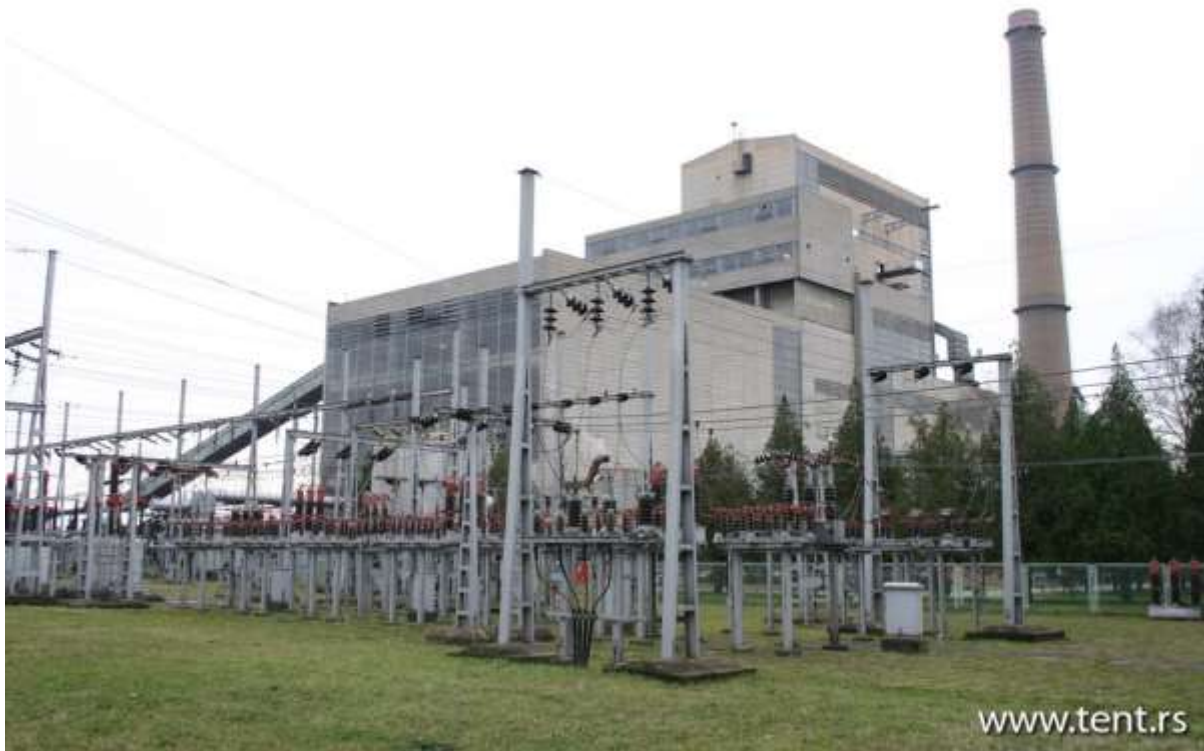
Picture 10. Thermal power plant "Morava", Svilajnac
