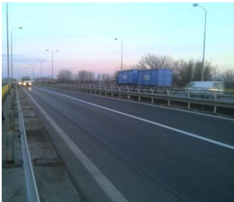
Слика 5. Мост на левој траци
