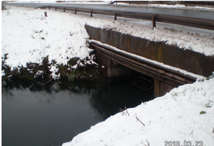
Слика 10. Каналски плочаст пропуст на км 38+060
