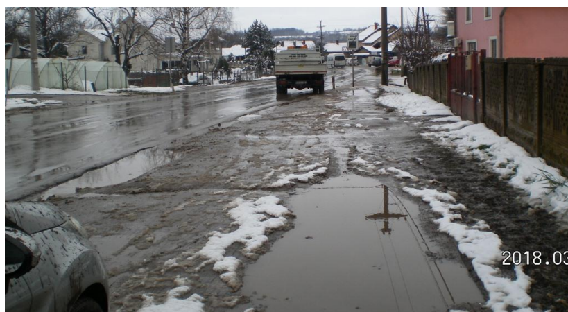
Слика 40. Насеље Раља – детаљ пута ИБ 14 без адекватне пешачке стазе км 48+610 до км 49+000
