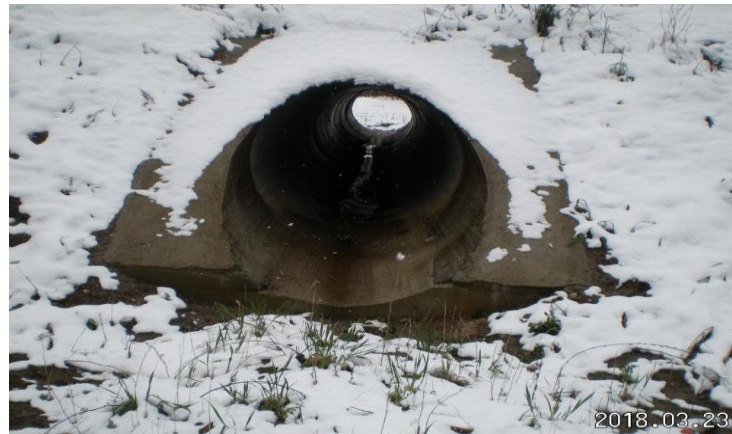
Слика 13. Цеваст пропуст \varnothing 1400 на км 10+337 – нема функцију
