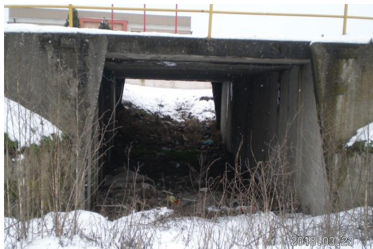
Слика 14. Плочаст пропуст на км 12+013 – нема функцију
