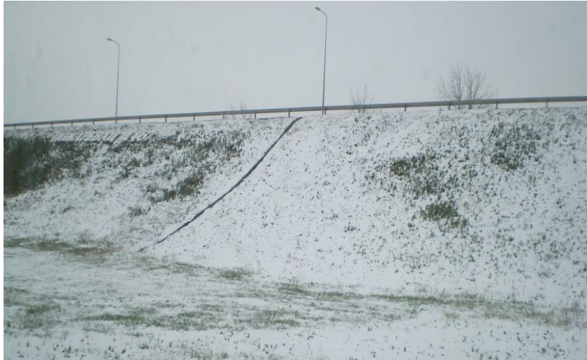
Слика 15. Самоупијајући отворени канал - ИБ 33
