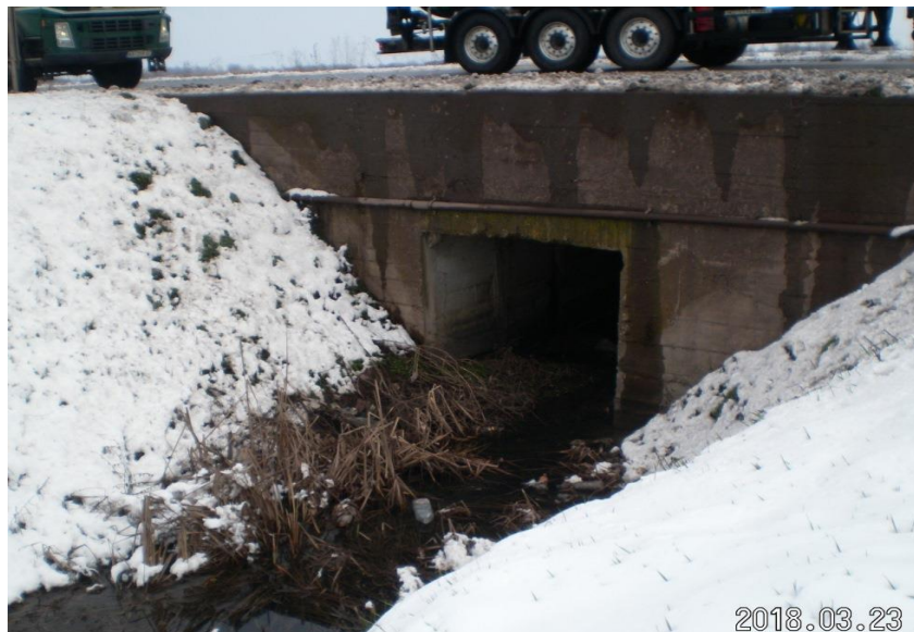
Слика 11. Каналски плочаст пропуст на км 38+489 – Балава бара
