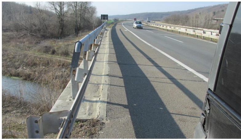
Слика 15. Мост преко Јовановачке реке на км 375+897
