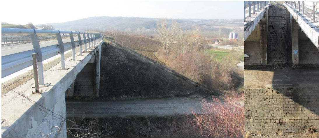
Слика 16. Мост преко пута и потока на км 377+926
