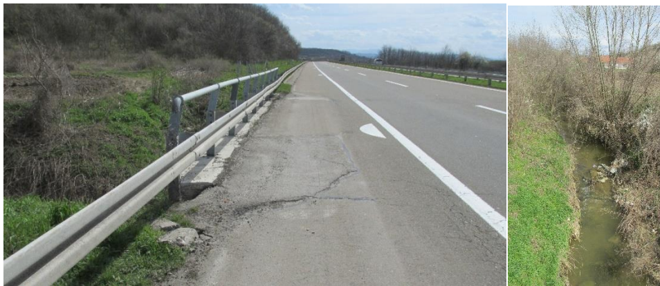
Слика 13. Мост преко Крежбијског потока на км 367+753
