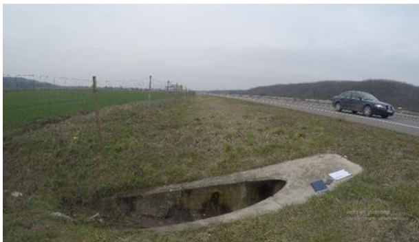
Слика 19. Цеваста пропуст на км 374+858
