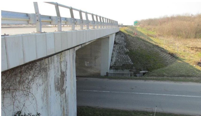
Слика 21. Мост преко пута 158Е на км 373+850
