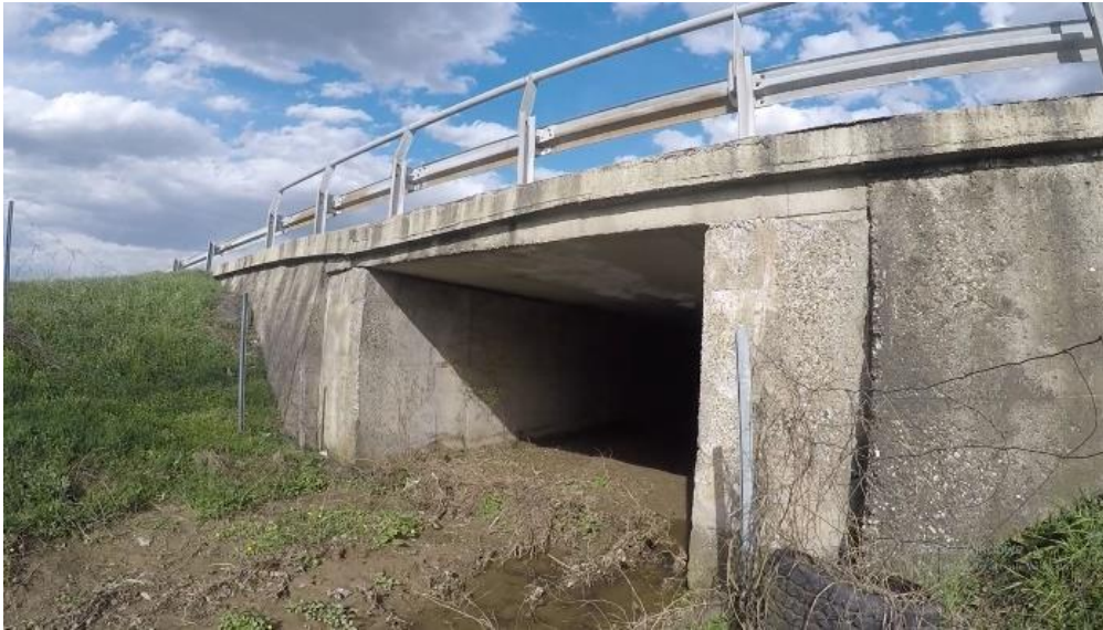
Слика 18. плочаста пропуста на км 363+822
