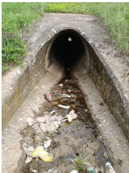
Слика 17. Засведен пропуст на км 361+767
