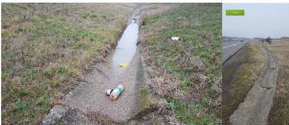
Слика 9. Бетонски канали на предметној деоници
