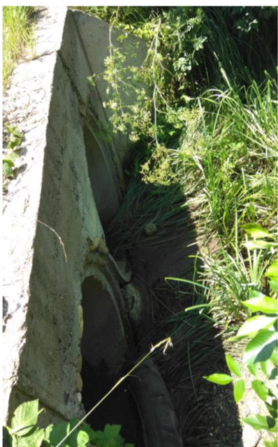
Слика 7. Пропуст \phi 1000 на км 190+106,43
