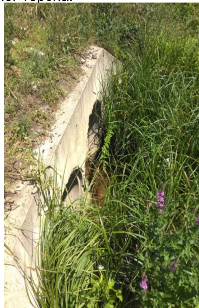
Слика 8. Пропуст \phi 1000 на км 190+106,43
