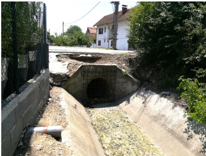
Слика 6. Неготин - попречно укрштање са бетонским каналом
