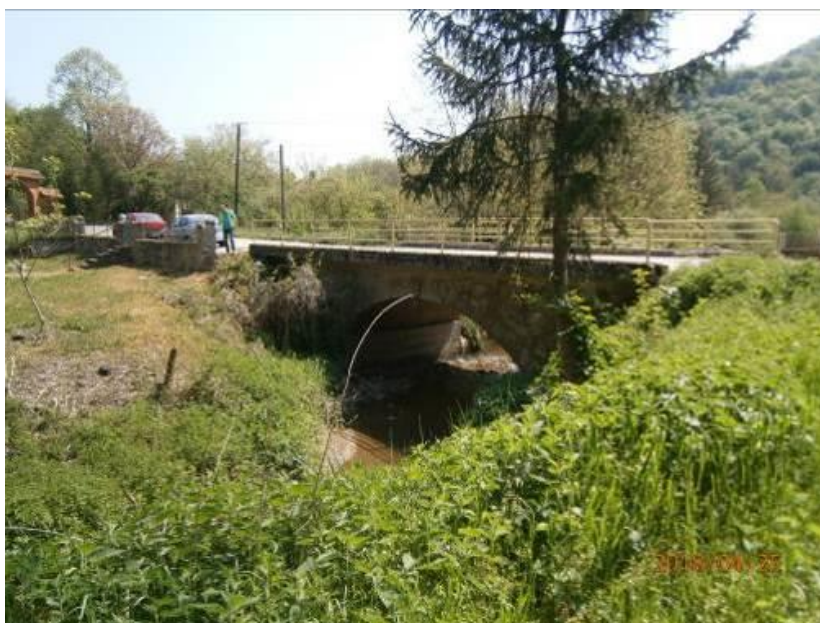
Слика 15: Мост преко реке Рђавице (Укрштај бр. 9)
