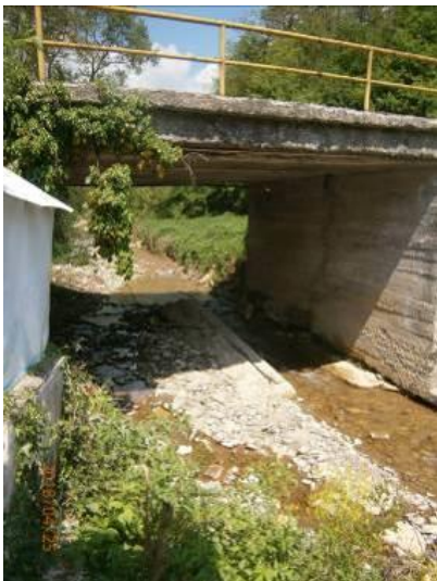
Слика 10 : Мост преко Долске Долине
