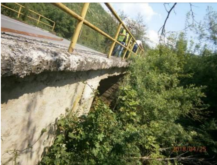
Слика 11 : Плочасти пропуст преко Брестовдолског потока
