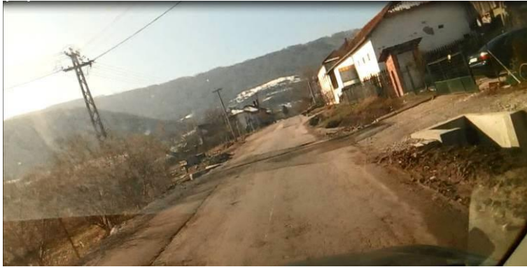
Слика 4: Уливна армирано-бетонска глава пропуста
