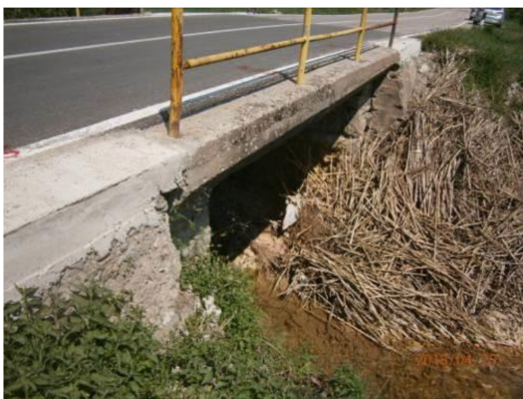
Слика 9: Плочасти пропуст преко реке Линовиштице
