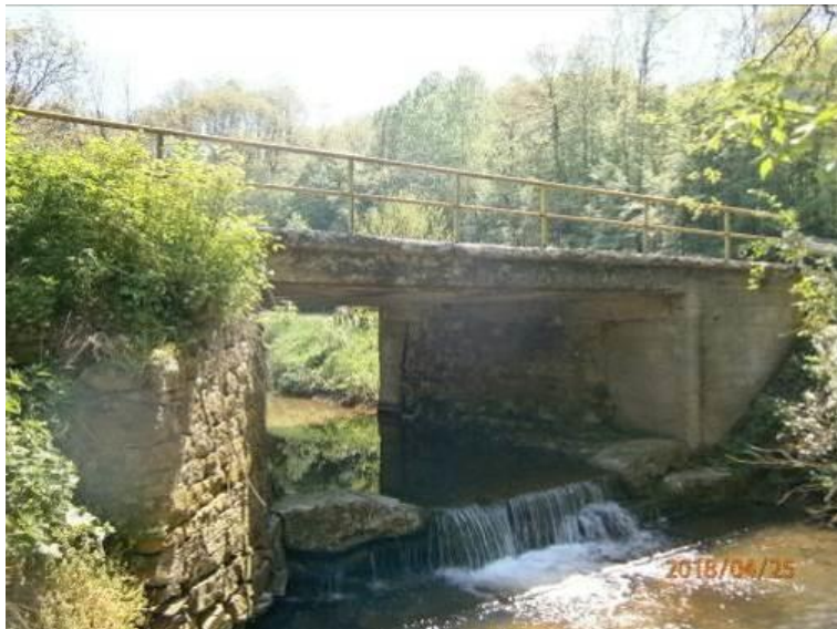
Слика 14 : Мост преко реке Рђавице (Укрштај бр. 8)
