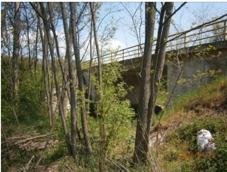
Слика 13: Мост преко реке Рђавице (Укрштај бр. 7)
