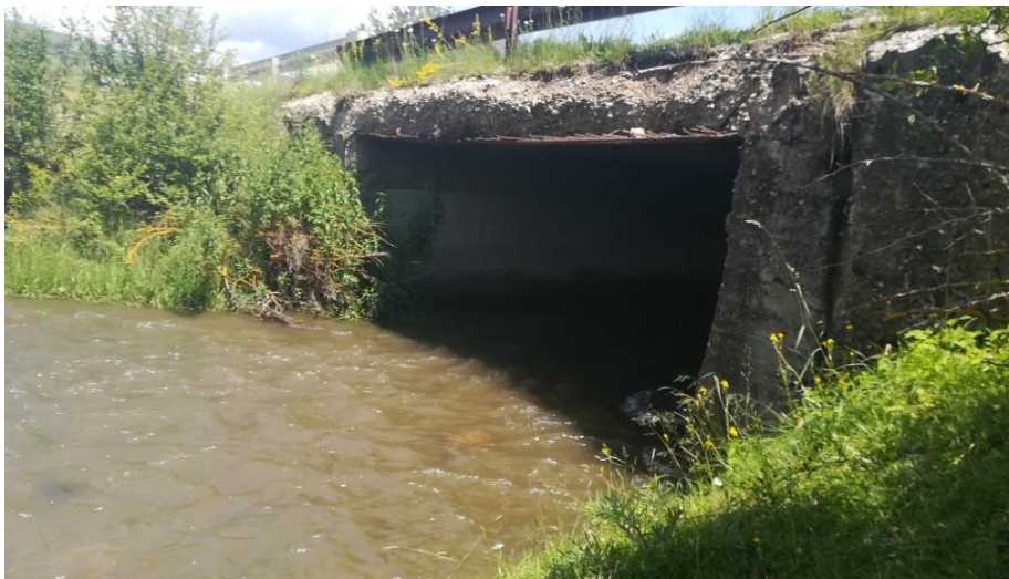
Слика 8. Мост на Брњичкој реци, km 71+646
