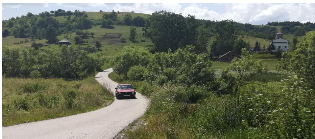
Слика 4. Детаљ пејзажа државног пута ИБ 29, село Штавалј
