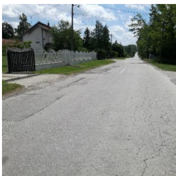
Слика 14. Оштећења коловоза
