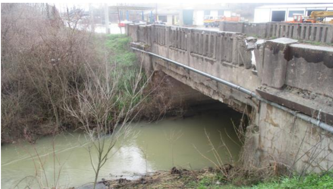
Слика 13. Мост са бетонском оградом (Деспотовац)
