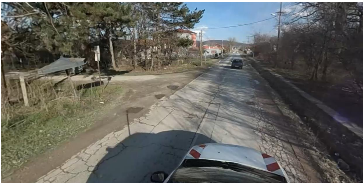
Слика 7. Постојеће аутобусно стајалиште у Деспотовцу са леве стране
