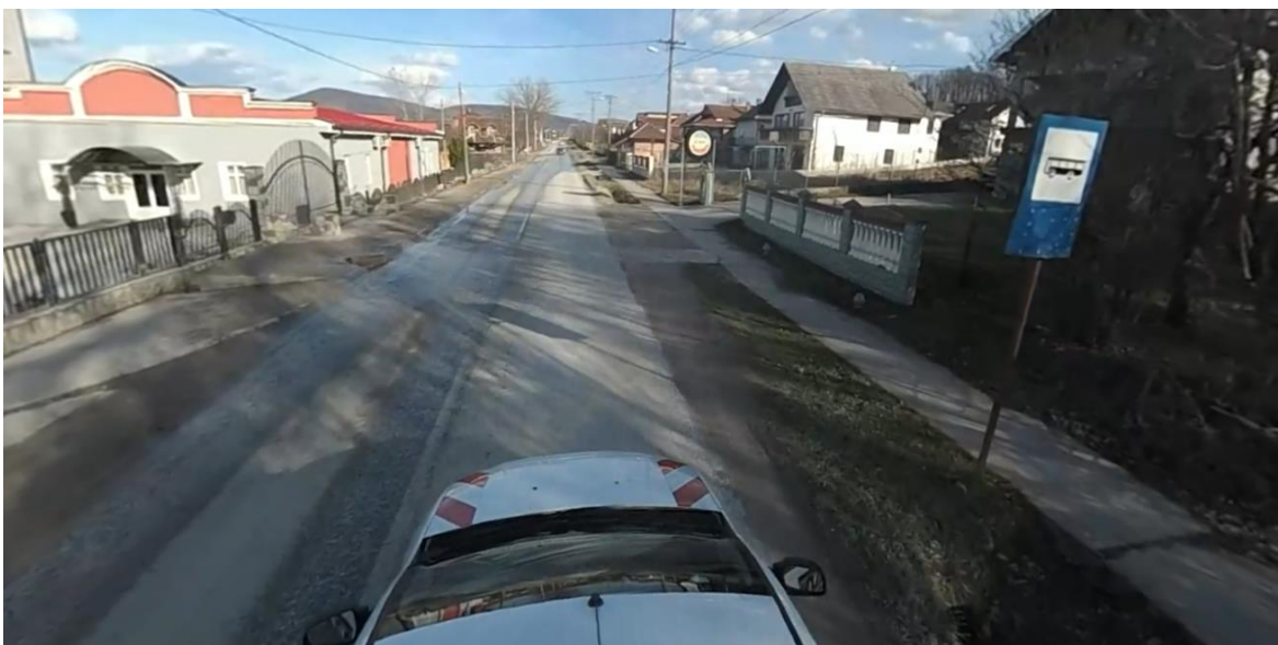
Слика 8. Постојеће аутобусно стајалиште у Деспотовцу са десне стране
