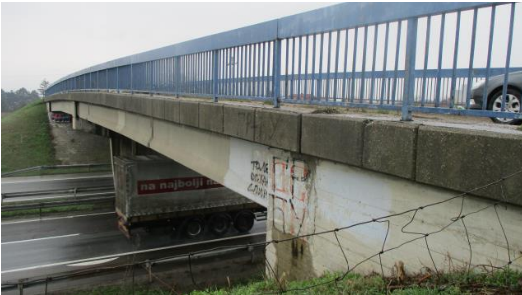
Слика 12. Надпутњак преко аутопута Београд - Ниш (Ђуприја)
