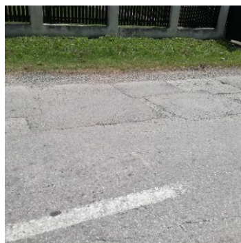
Слика 14. Оштећења коловоза
