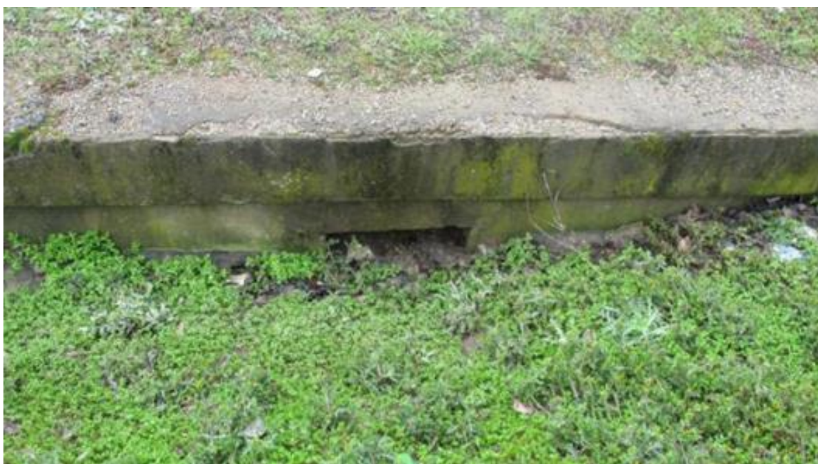
Слика 20. Затрпани путни пропуст
