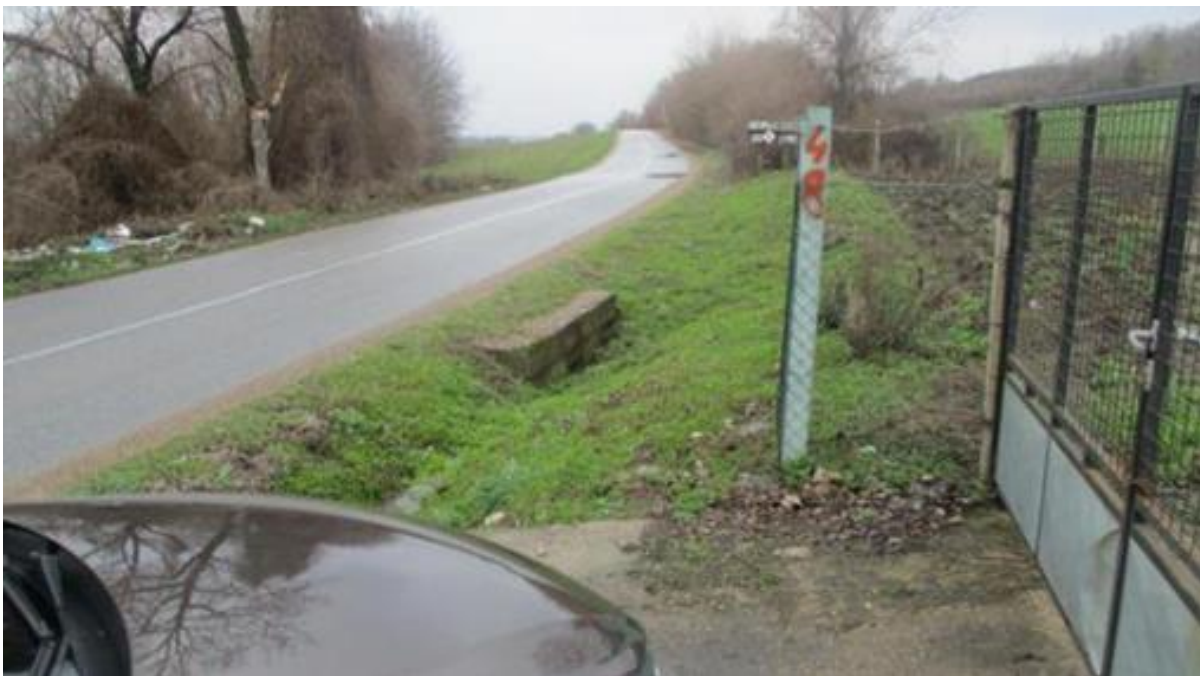
Слика 23. Дивња депонија - уливна глава пропуста
