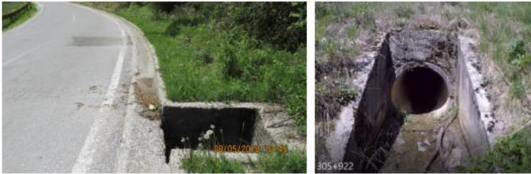
Слика 20. Комбиновани пропуст на км 305+922
