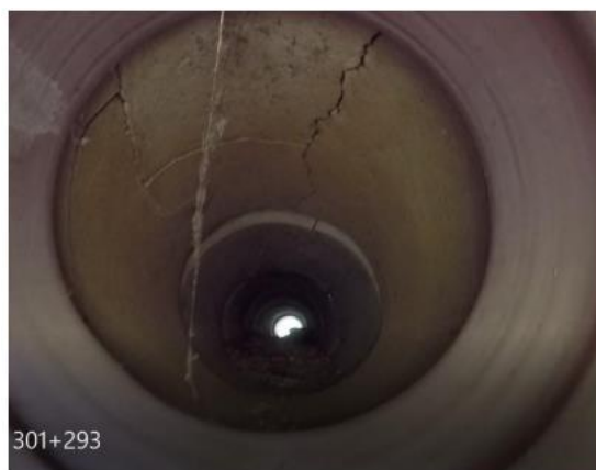
Слика 189. Цевасти пропуста на км 301+293
