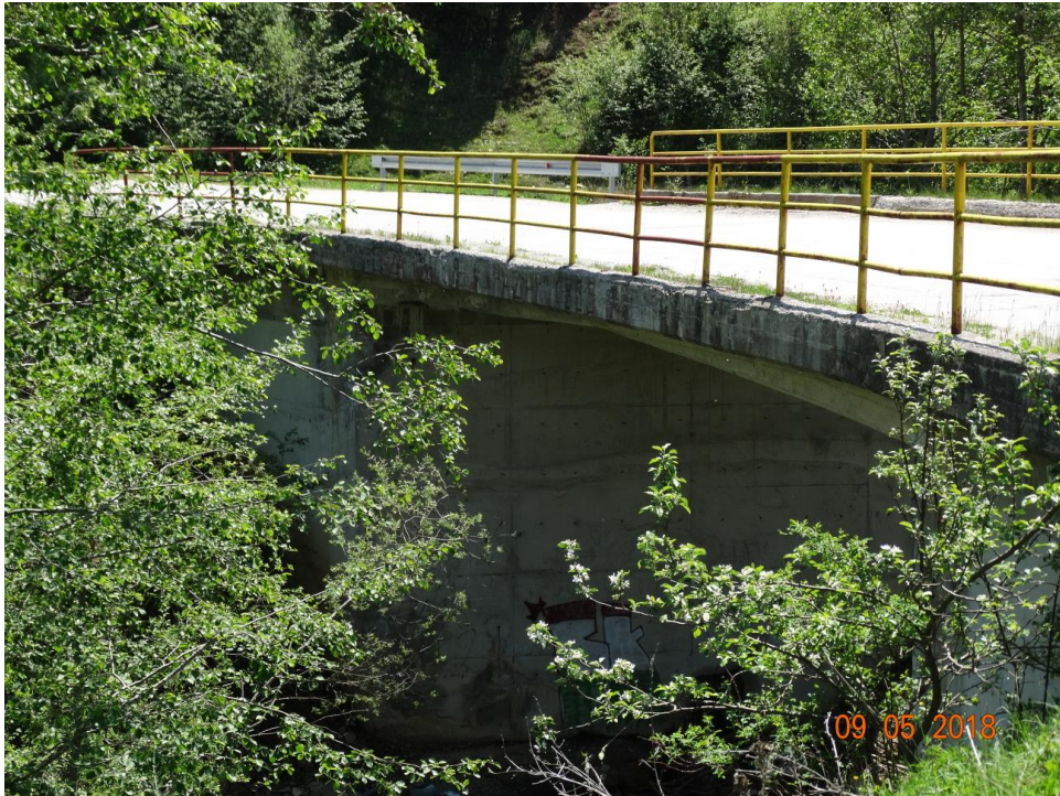
Слика 15. Мост преко Кладничке река на км 292+810
