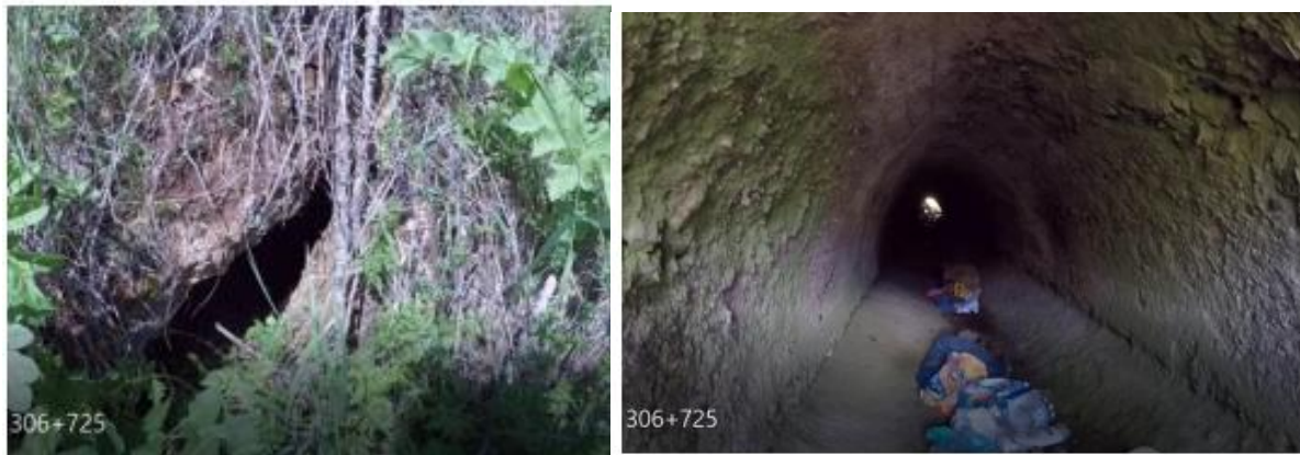
Слика 178. Засведен пропуст на км 306+725
