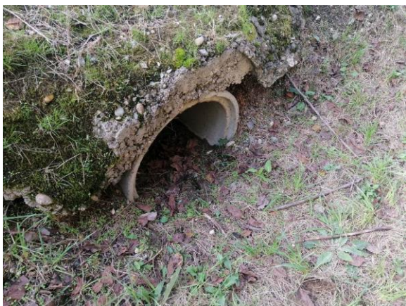
Слика 2-35 Цеваст пропуст, на км 36+392
