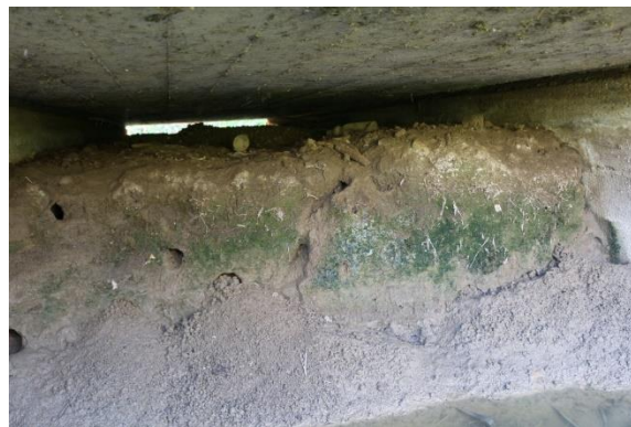
Слика 2-39 км 30+498 пропуст запуњен материјалом
