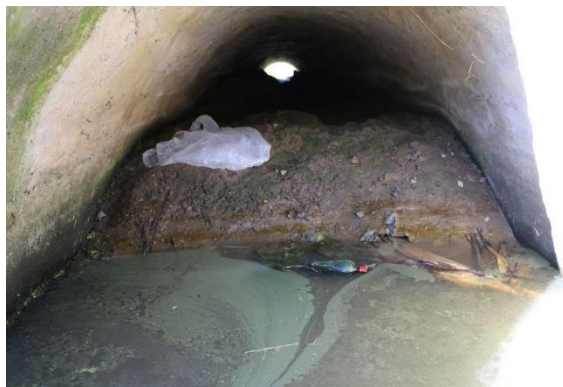
Слика 2-38 км 28+873 пропуст запуњен материјалом
