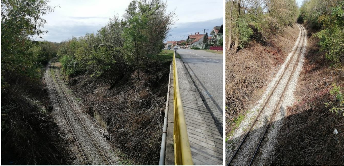
Слика 2-28 Денивелисано укрштање пруге и предметне деонице, Сираково, на km 21+890
