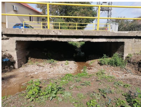
Слика 2-36 Плочаст пропуст, на км 32+800
