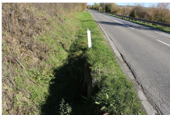
Слика 2-42 km ~27+100 јарак неадекватног облика
