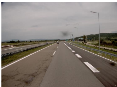
Слика бр. 38 Оштећења коловоза
