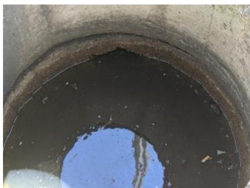
Слика бр. 18 - Задржавање воде у шахту
