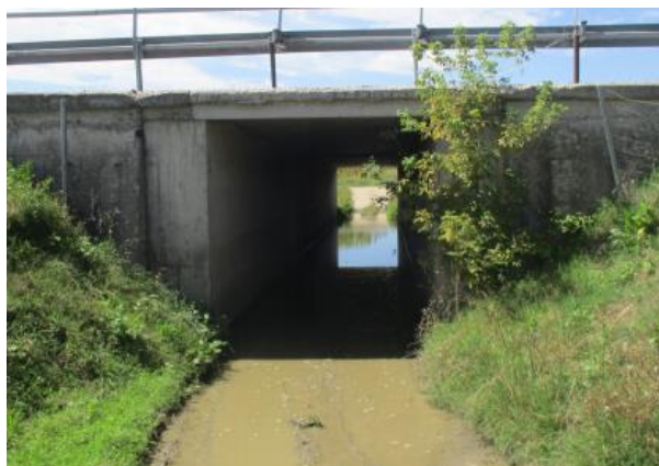
Слика бр. 26- Плочасти пролаз на км 451+737
