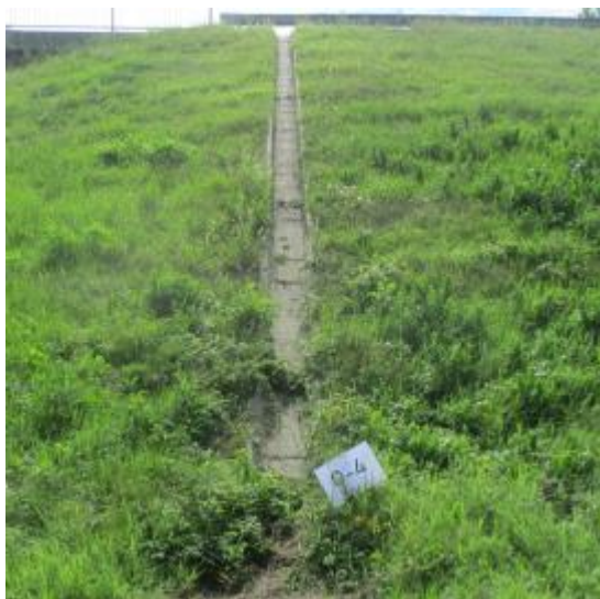
Слика бр. 25 - Типски изглед стања корубе
