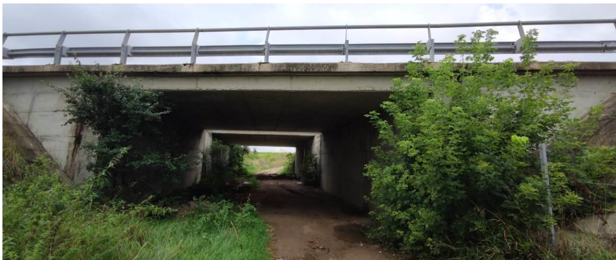
Слика бр.31: Поглед на мост са стране, са локалног пута
