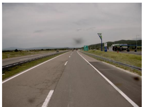
Слика бр. 39 Оштећења коловоза
