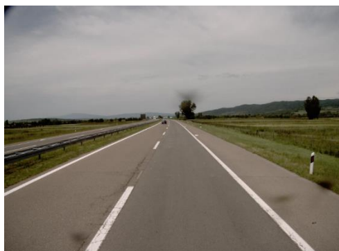
Слика бр. 36 Оштећења коловоза
