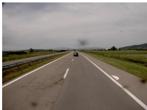
Слика бр. 37 Оштећења коловоза
