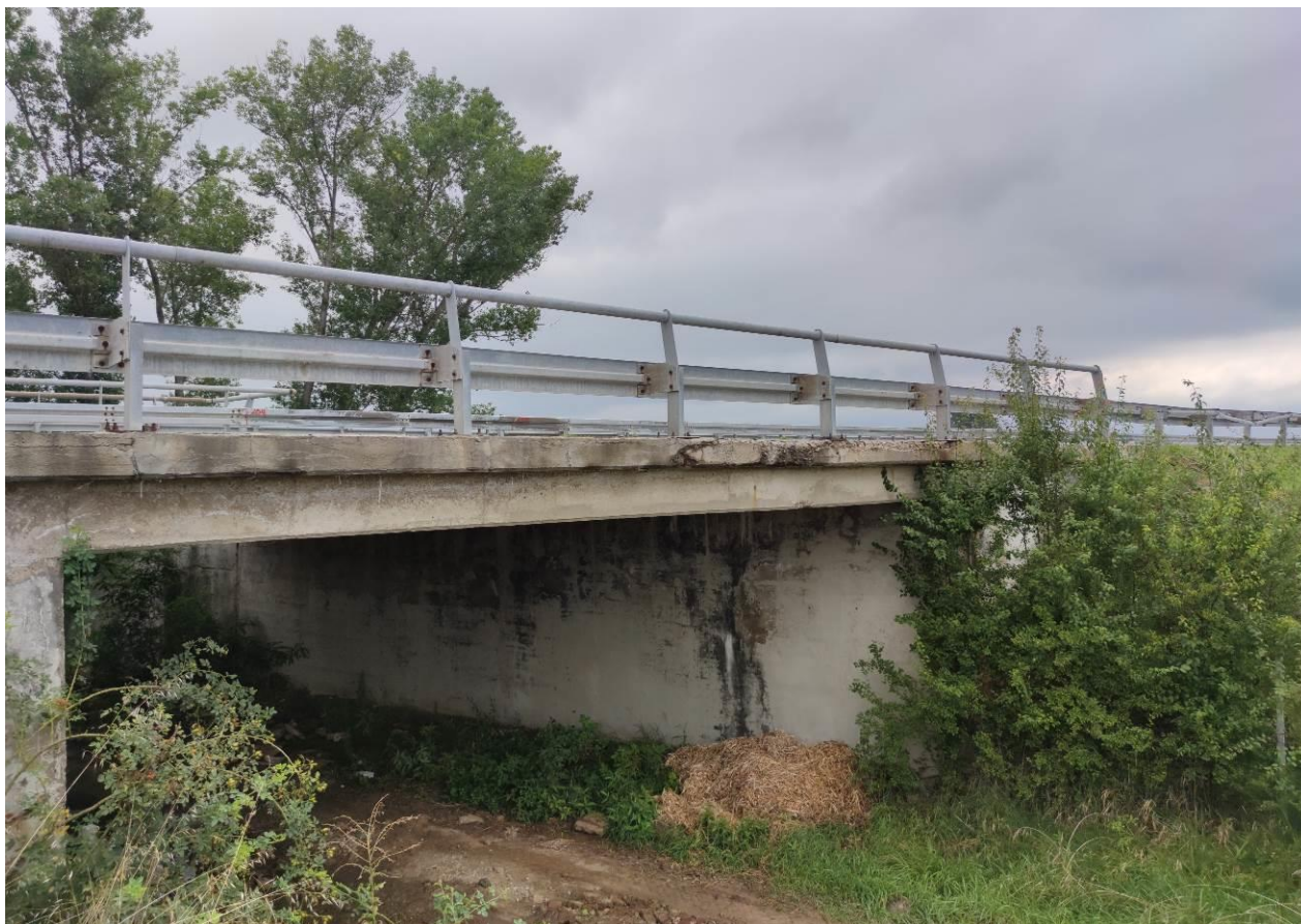
Слика бр. 34: Кегле зарасле у растиње, неодржавана зона испод моста, оштећења венца моста
