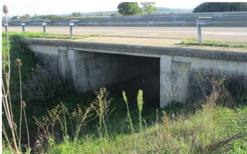
Слика бр. 10 - Плочаст пропуст на стационажи km 454+935 и Водоток «Бара»
