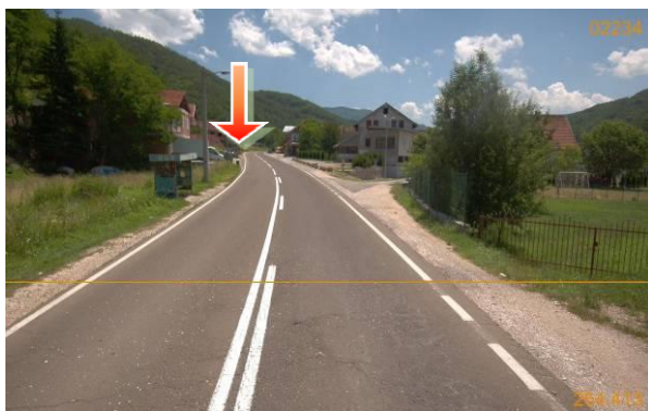
Слика 10. Неизграђено стајалиште на км 264+425
