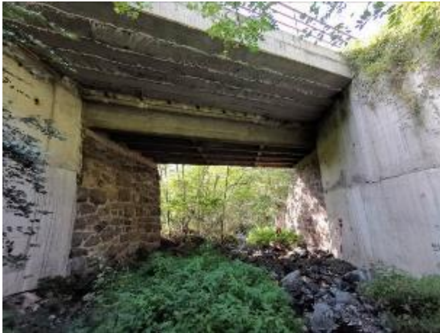
Слика 7: Мост преко Марковске реке (стац. км 212 + 229)
