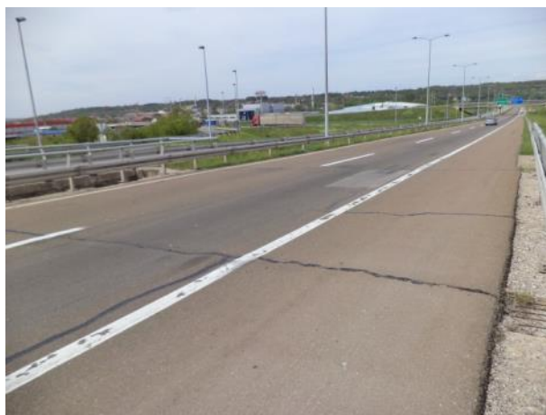
Пукотине у асфалтном застору леве коловозне траке
