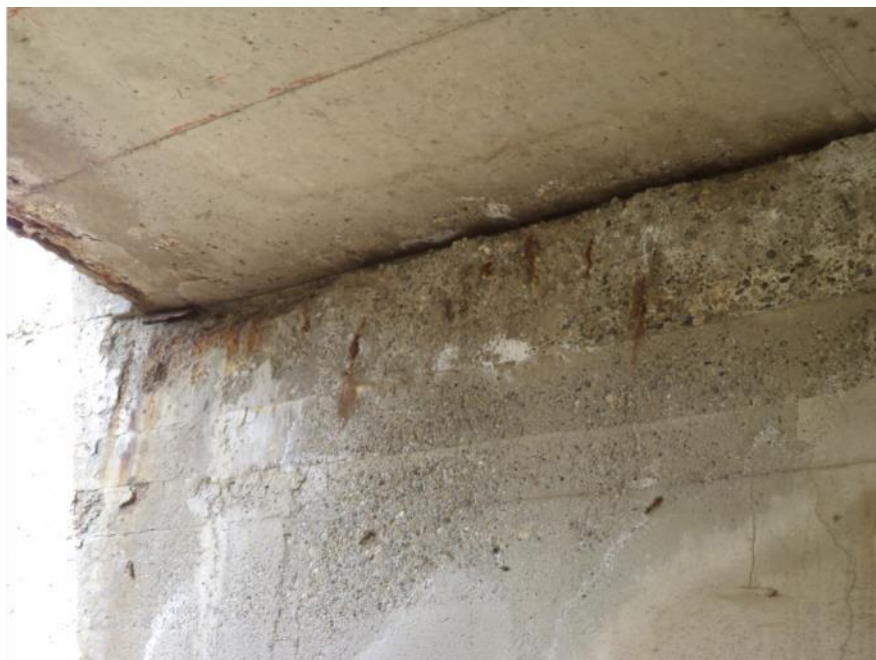
Отпао заштитни слој, видљива арматура Стуб ка Београду
