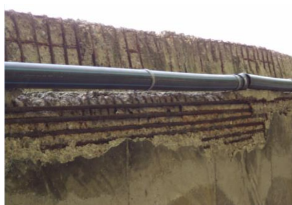
Мост на десној траци –десна ивица плоче
