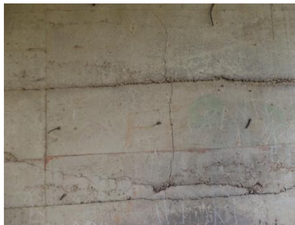
Сегрегације и прслине у бетону субова ка Београду
