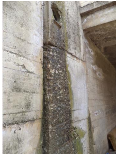
Видљива и оштећена арматура Стуб ка Нишу – између трака
