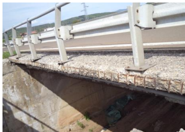
Мост на левој траци – десна ивица плоче
