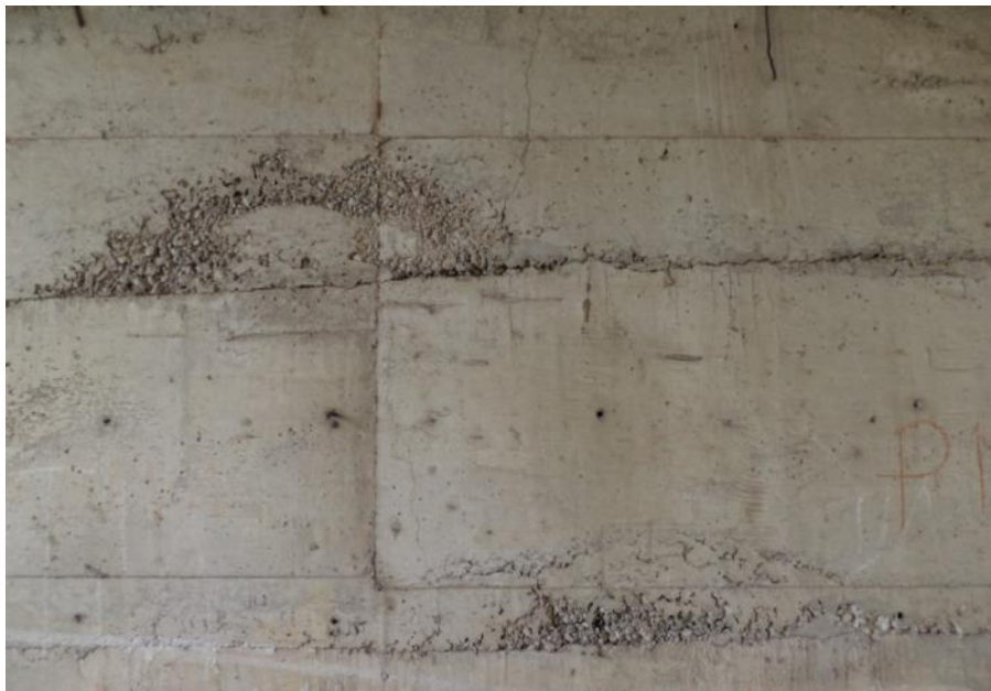
Сегрегације и прслине у бетону субова ка Нишу
