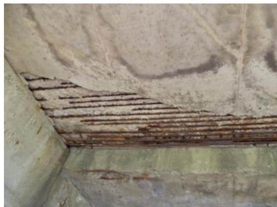
Мост на левој траци – место подужне дилатације
