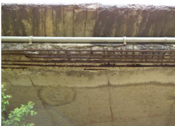
Мост на десној траци – десна ивица плоче
