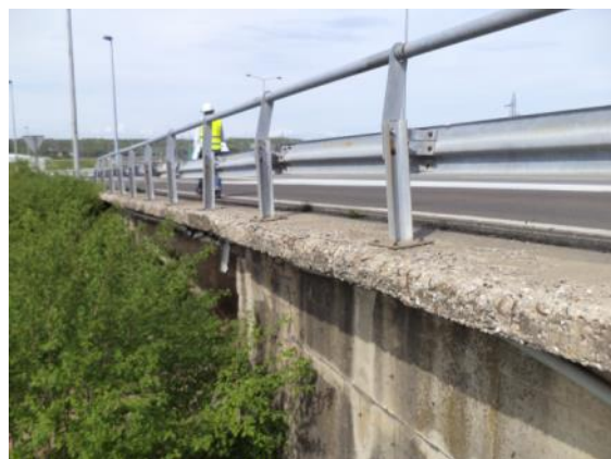
Мост на десној траци – десна ивица плоче
