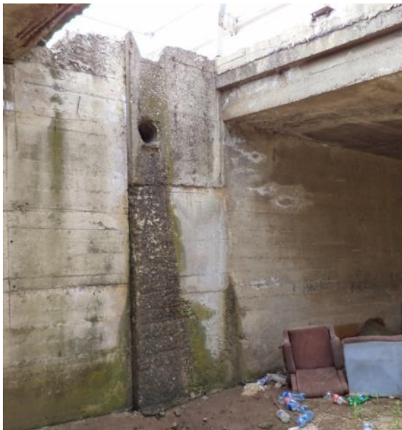
Видљива и оштећена арматура Стуб ка Нишу – између трака
