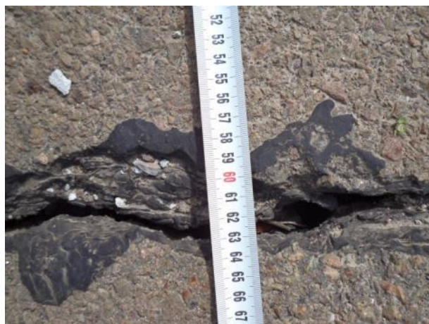
Ширина пукотине леве коловозне траке са стране Ниша
