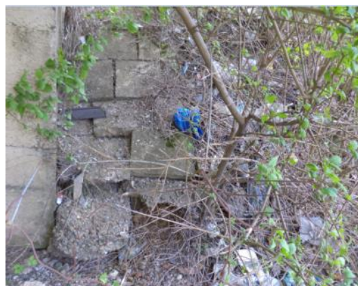
Кегла на стубу ка Нишу – десна трака Стање темеља кегли
