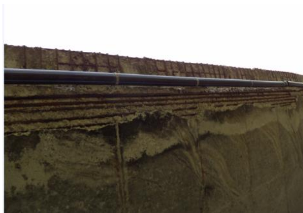
Мост на десној траци –десна ивица плоче
