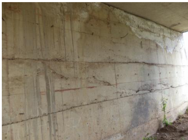
Сегрегације и прслине у бетону субова ка Београду
