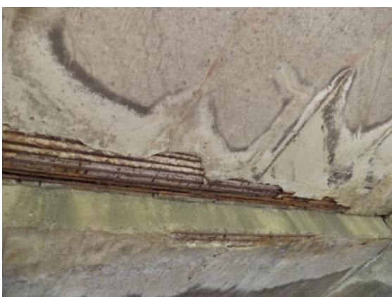
Мост на левој траци – место подужне дилатације
