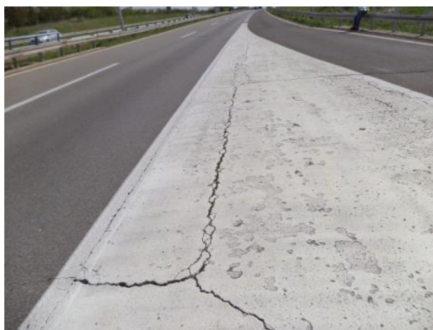
Подужна пукотина на месту подужне дилатације између старог и новог моста десне траке, попречна пукотина новог моста
