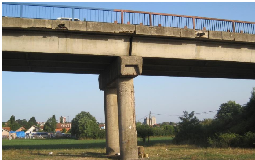
Слика 1. Постојећи изливи са моста (неконтролисано одвођење)
