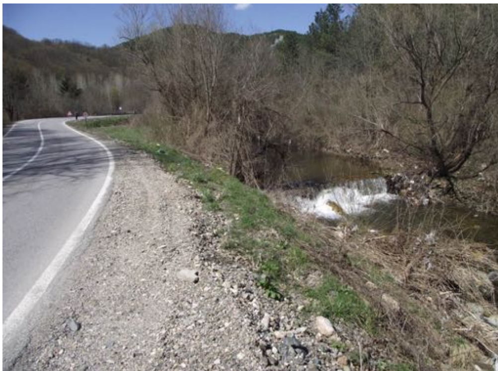
Слика2. 2. Речни праг са каскадом низводно од моста
