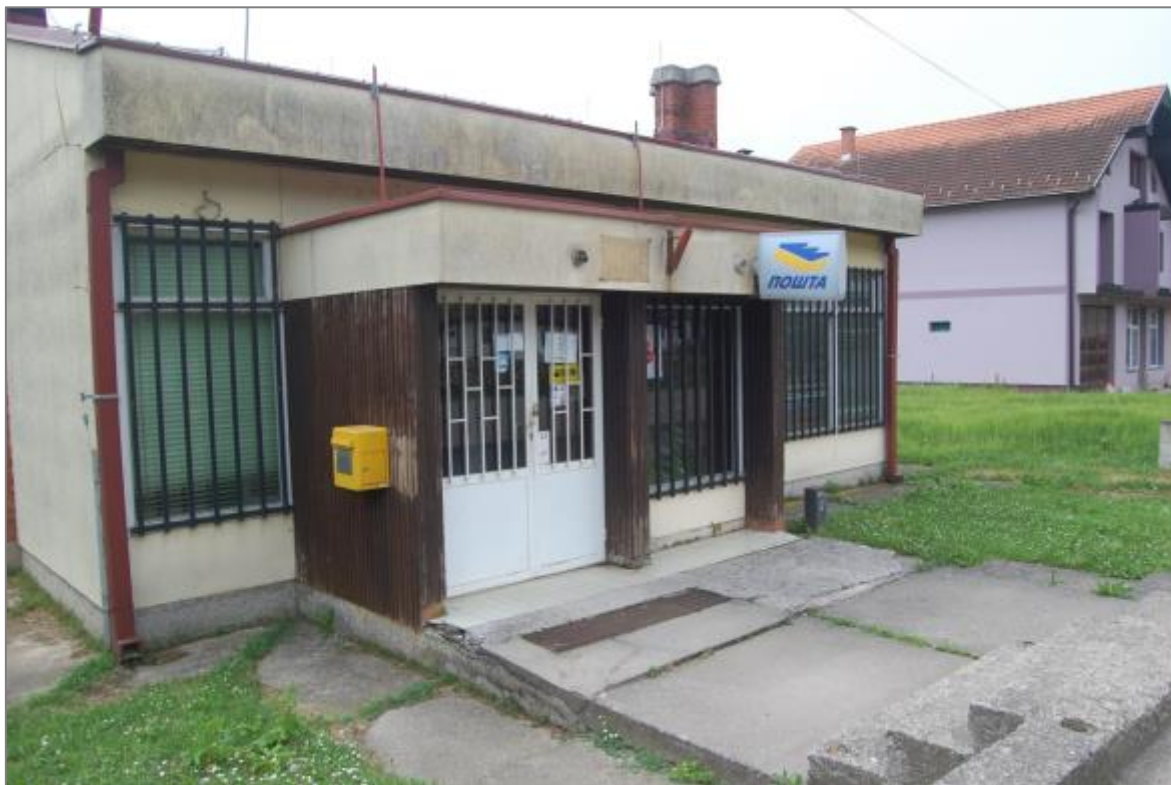
Picture 21. Postoffice, Uzovnica
