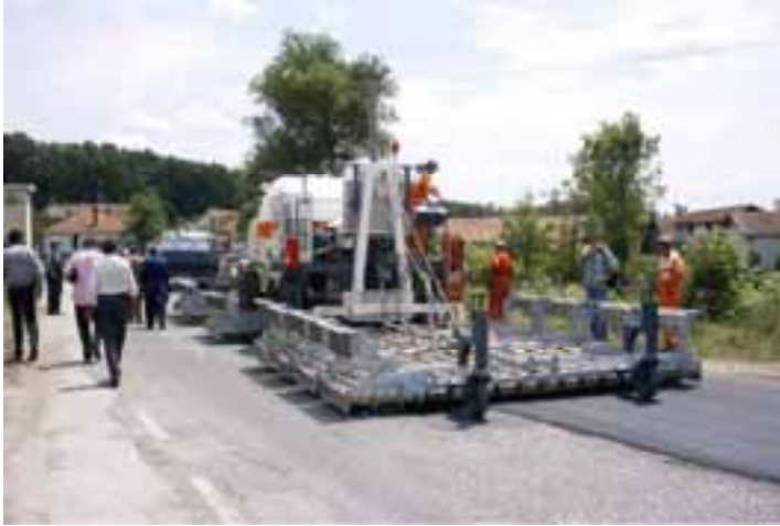
Слика 12.29 Самоходна машина која почетно загрева асфалтни застор инфрацрвеним грејачима (у зависности од спољних услова може да се укључи још једна машина)
