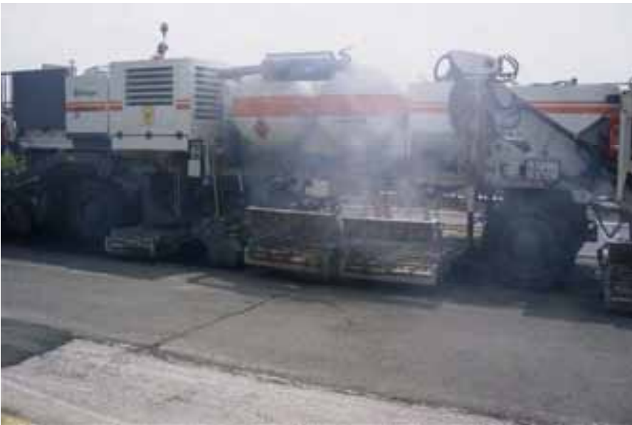
Слика 12.24 Постројење за обраду асфалтног коловоза по топлом поступку
