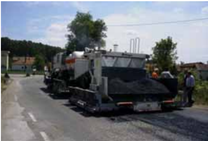
Слика 12.28 Централна јединица машине за прераду асфалт бетона - Remixer 4500 (фирме Wirtgen)
