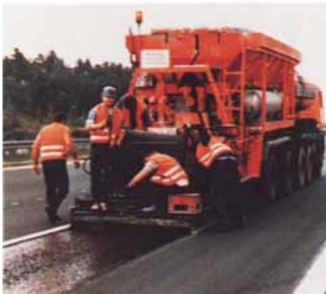
Слика 12.7 Попуњавање колотрага микро-застором
