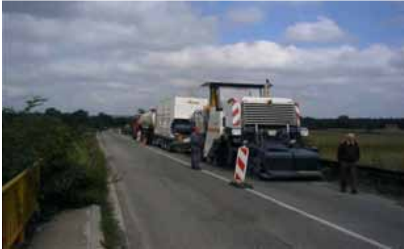
Слика 12.14 Испумпавање битумена у машину на путу М-22
